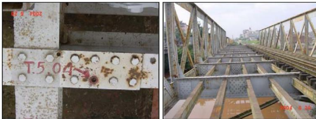
Figura 1. Corrosión atmosférica de un puente ferroviario en Vietnam (Popov, 2015).
