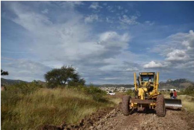
**Figura 52: Construcción de camino alternativo en Villas de Guanajuato**
