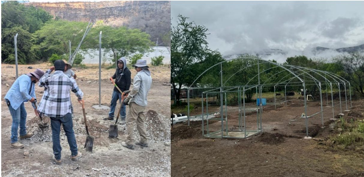
Imagen 8. Inicio de la construcción del invernadero (Fuente: elaboración propia)
