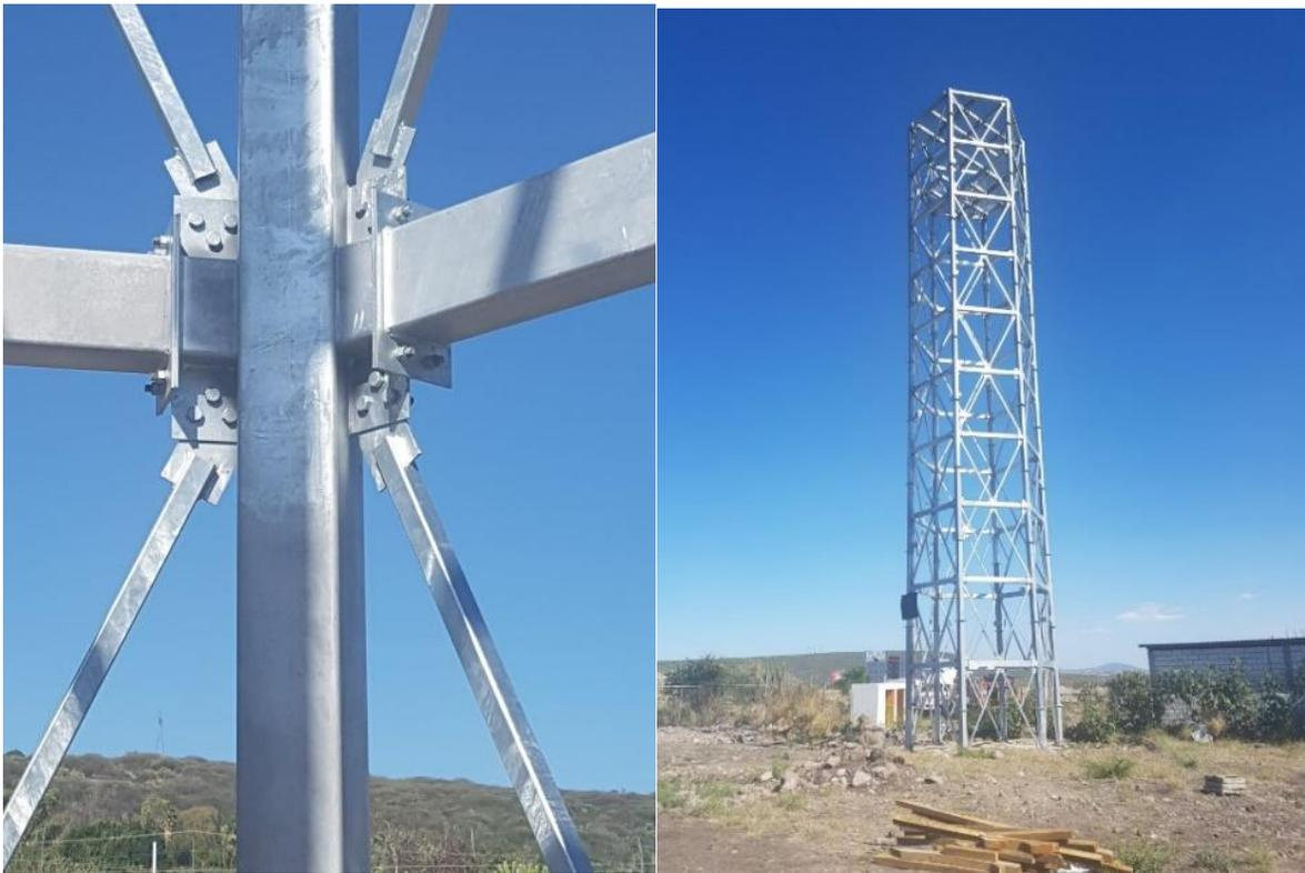
Figura 2-9 Fotos de torre de Heliostatós de la UAQ. A) Conexiones tipo en todos los nodos.
