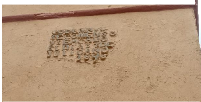
IMAGEN 1. FOTO DE LA FECHA DE CONSTRUCCIÓN DEL TEMPLO DE SAN ANTONIO DE LA PUNTA.
