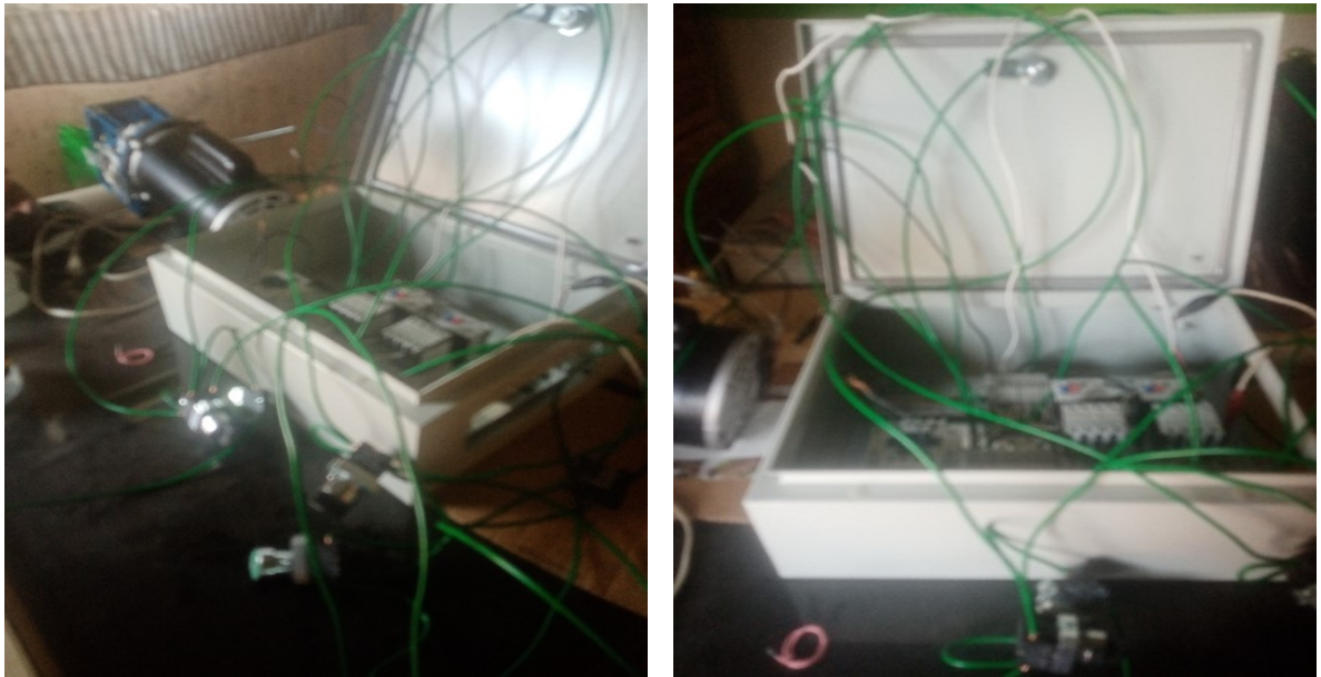
Figura 21: Pruebas de las conexiones en la etapa de potencia.
