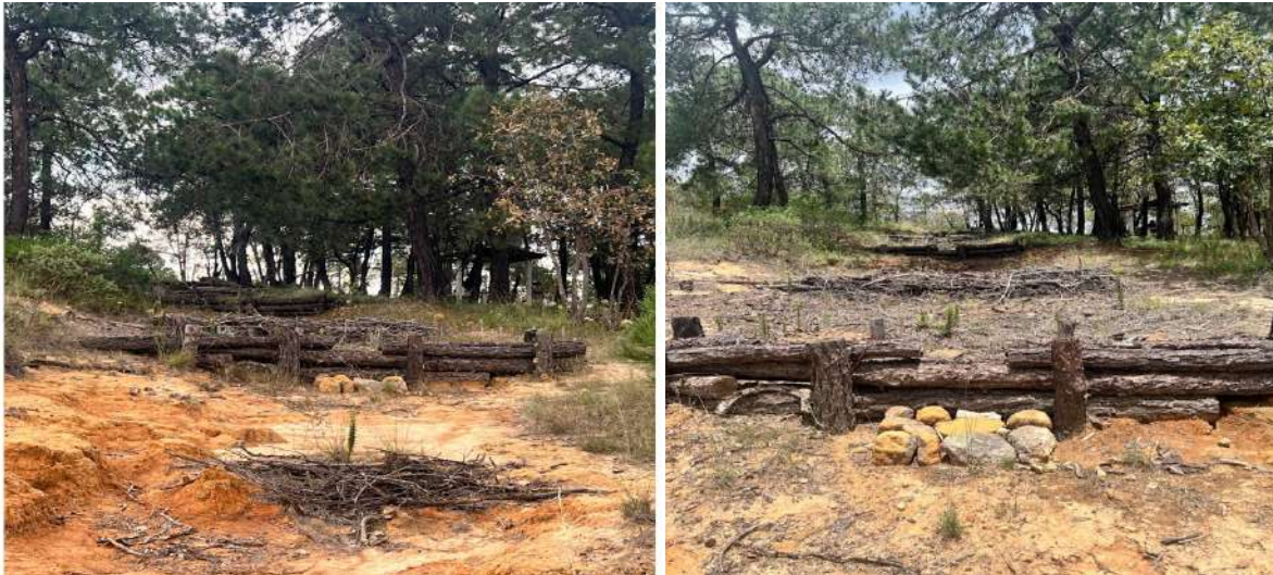
Figura 31. Presas de morillos construidas en el sitio 3.
