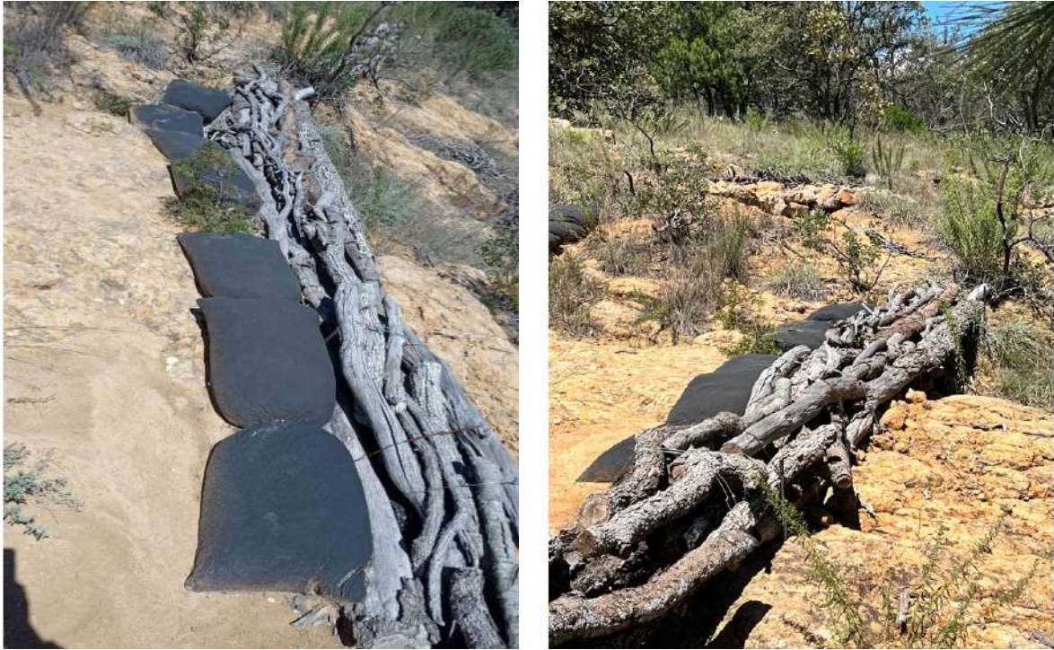
Figura 29. Barreras muertas con geocostales aguas arriba, se observa un terreno irregular que provoca diferentes espesores en el sedimento retenido.
