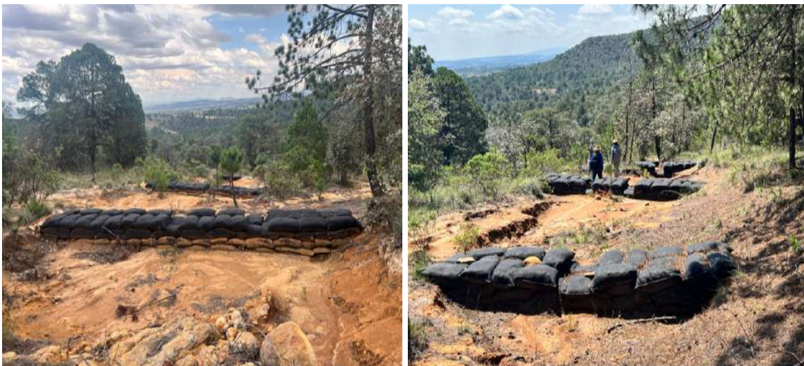
Figura 32. Presas de geocostales, el geotextil se encuentra en buen estado y se aprecia la longitud de las presas.
