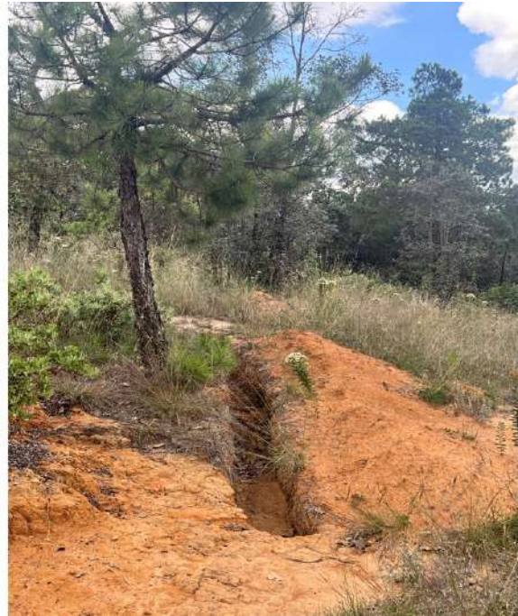
Figura 35. Zanjas trinchera construidas en el sitio 3, se aprecia que el bordo no esta protegido de ninguna manera.
