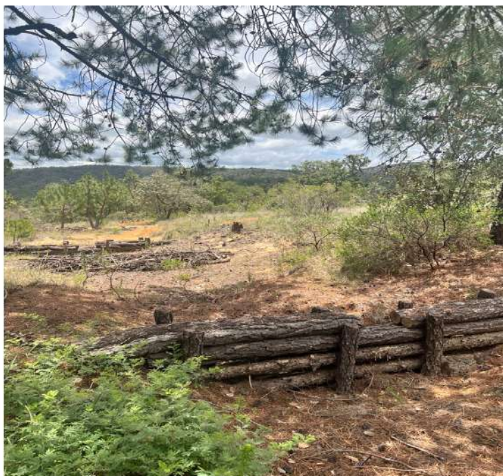
Figura 33. Barreras muertas localizadas a 5 m de distancia entre presas de morillos.
