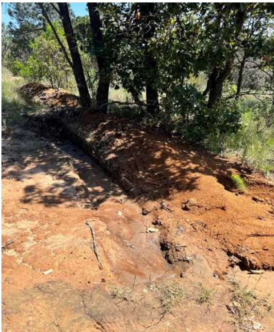
Figura 36. Zanajas trinchera rellenas de sedimentos y agua de lluvia.
