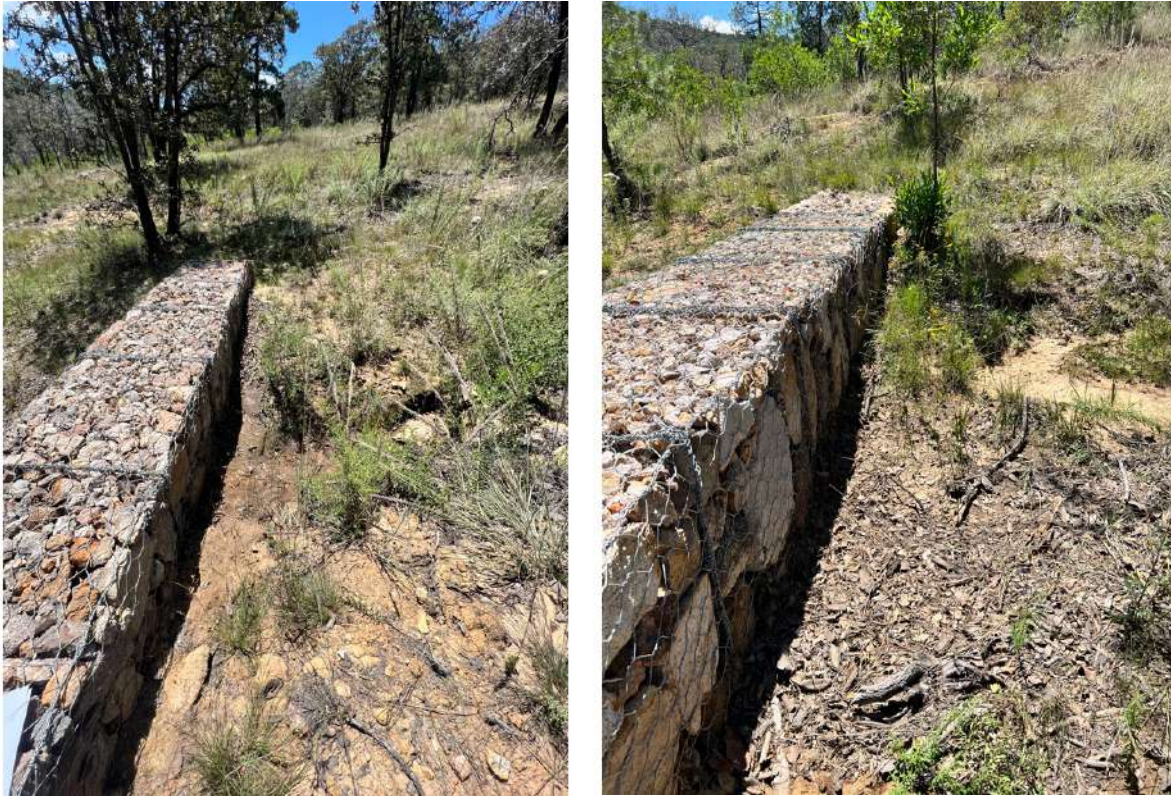
Figura 28. Presas de gaviones localizadas en el sitio 2, se observa que las jaulas mantienen su estructura y se encuentran en buen estado, además hay tanto hojarasca como suelo retenido.
