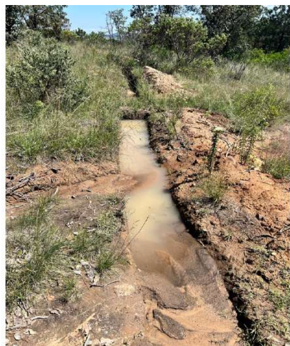
Figura 36. Zanajas trinchera rellenas de sedimentos y agua de lluvia.
