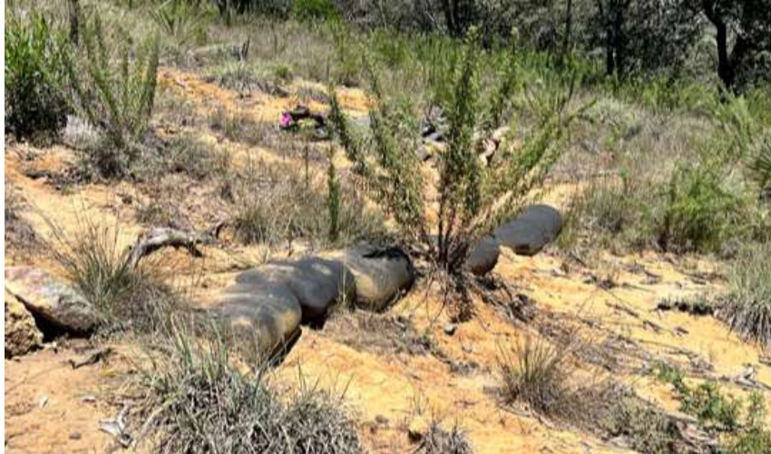
Figura 27. Geocostales sin empotrar, localizados en la parte media de la cárcava.
