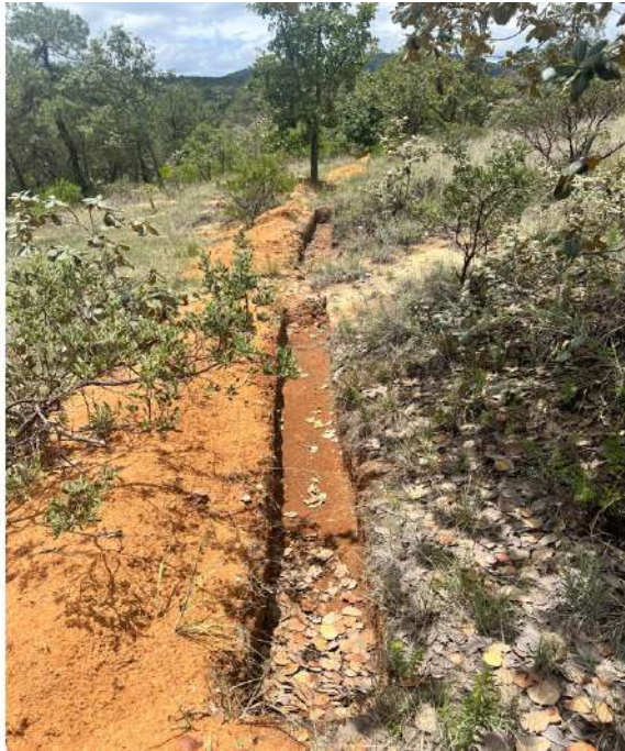
Figura 35. Zanjas trinchera construidas en el sitio 3, se aprecia que el bordo no esta protegido de ninguna manera.
