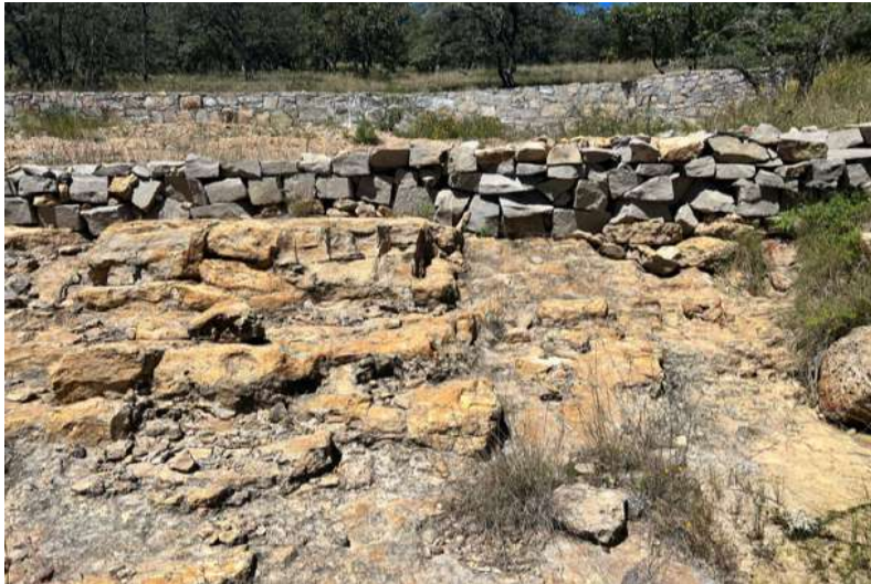
Figura 23. Presa de gaviones que mantiene su estructura y se encuentra en buen estado en el sitio 1, además se observa la roca expuesta aguas abajo.
