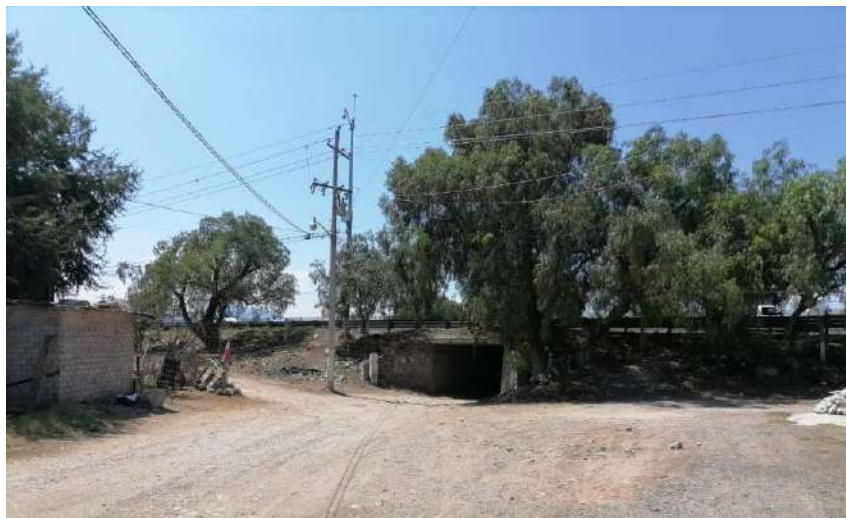
Imagen 9. Túnel debajo de la carretera 45D, Martínez Y., 2023
