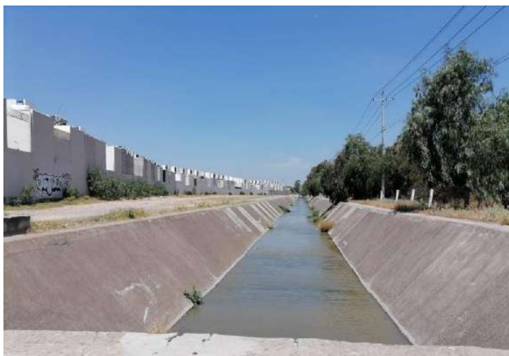
Imagen 8. De lado izquierdo se observa el residencial Misión La Joya y del lado derecho se encuentra instalada la carretera 45D, Martínez Y., 2023
