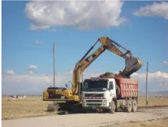
Figura 2.11. Volquete en trabajos de acarreo de material (Caterpillar).
