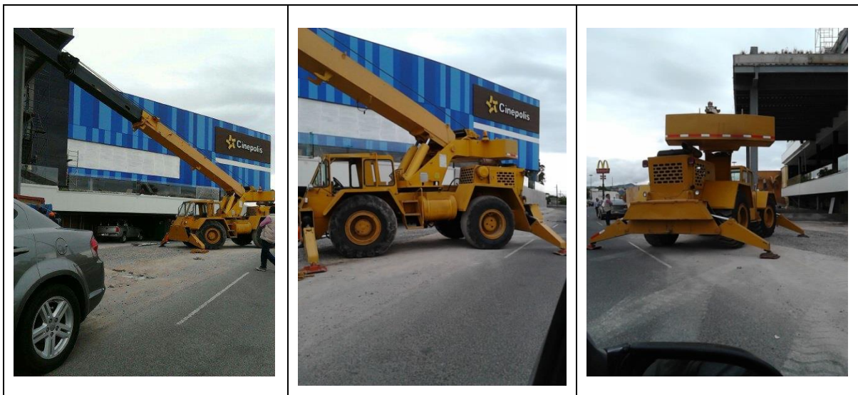
Figura 2.31. Grúa móvil sobre neumáticos en trabajos de montaje para la construcción de edificaciones.
