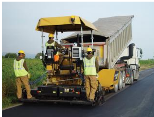
Figura 2.22. Pavimentadora asfáltica cargada por un camión articulado (Caterpillar).
