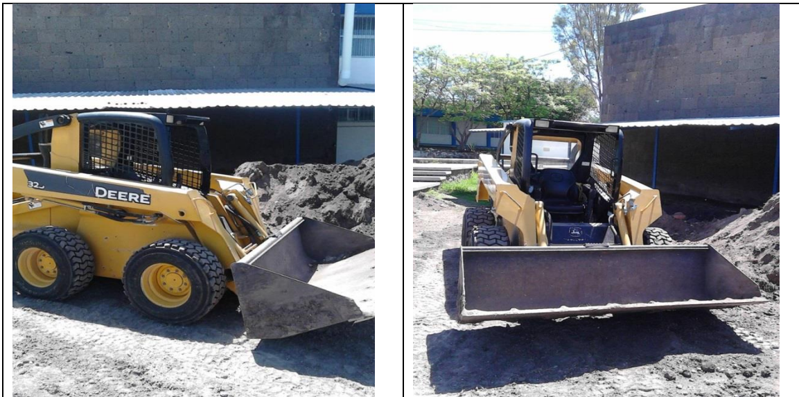
Figura 2.7. Minicargadora frontales en trabajo de movimiento de tierras.
