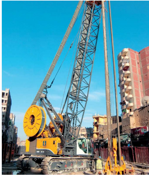
Figura 2.29. Máquina portadora de martinete de suspensión (martillo hidráulico, martillos diésel, accionamientos de perforación), ( directindustry ).
