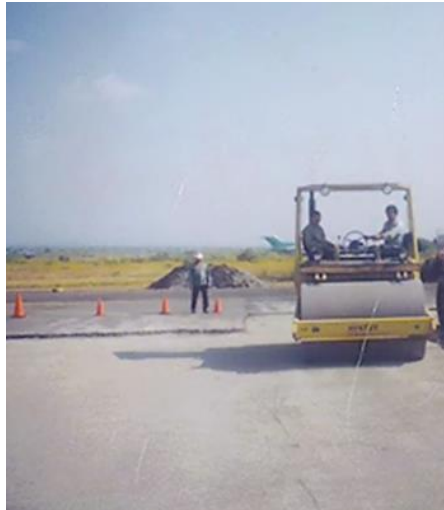
Figura 2.15. Aplanadora de rodillo liso en trabajos de Aeropuerto.
