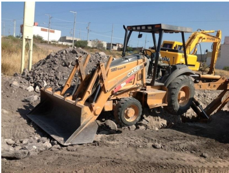
Figura 2.8. Retroexcavadora Cargadora operando en trabajos de trincheras para construcción de redes de agua potable.
