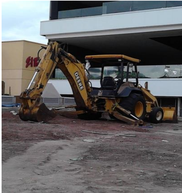
Figura 2.4. Retroexcavadora Cargadora en trabajos de terracerías para construcción de edificaciones.
