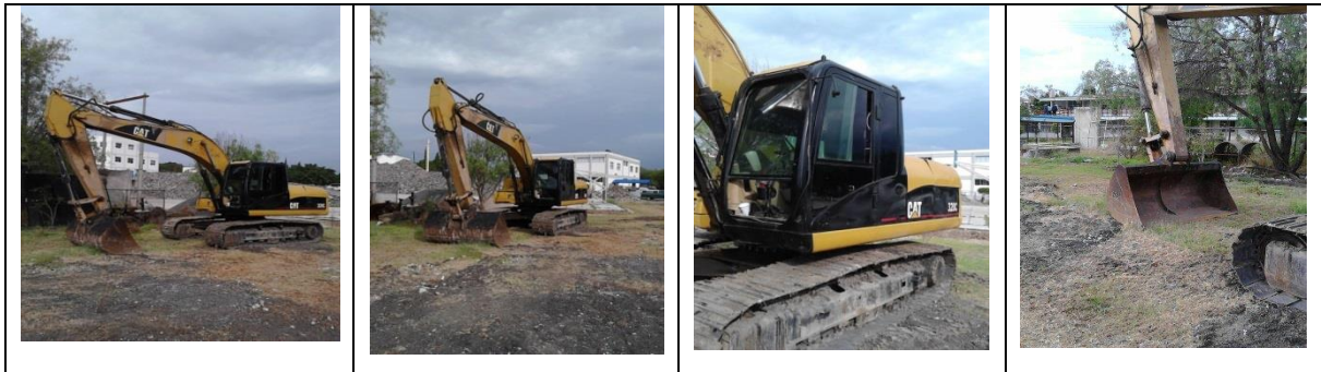
Figura 2.5. Retroexcavadora sobre orugas en trabajos de terracerías para construcción de edificaciones.
