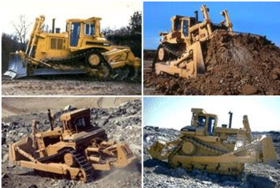
Figura 2.1. Tractores operando en trabajos de corte y empuje ( Finning Caterpillar ).
