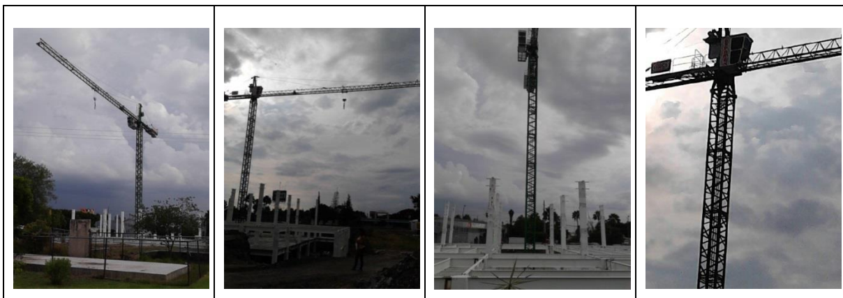
Figura 2.34. Grúa torre para trabajo de montaje en la construcción de edificaciones.
