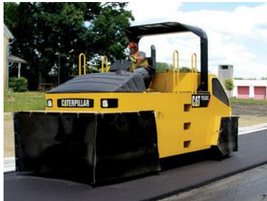
Figura 2.16. Compactador de neumáticos en operaciones de sellado de asfalto (Caterpillar).
