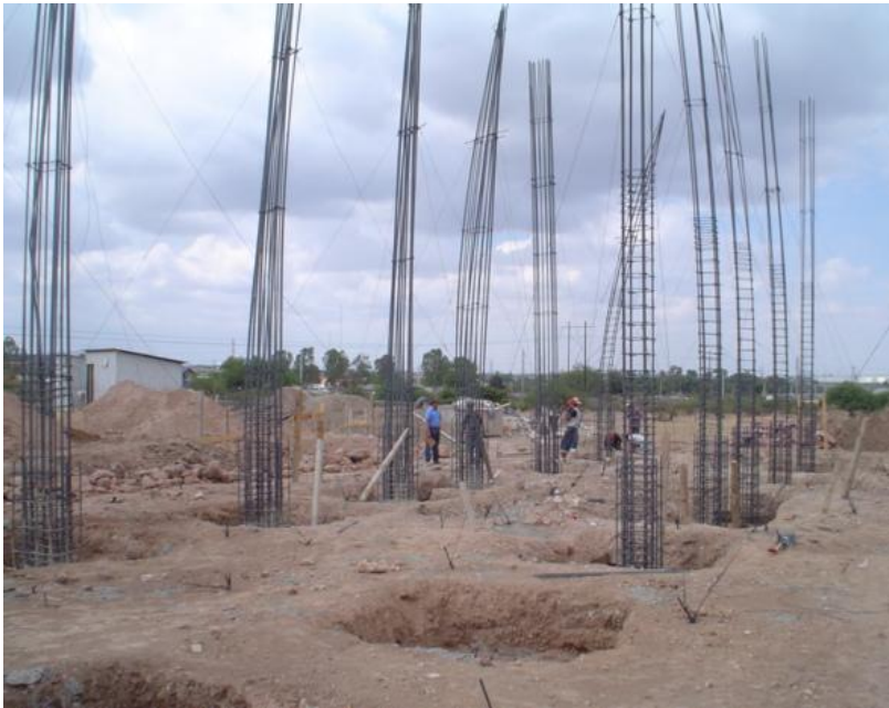
Supervisión de anclaje de columnas
