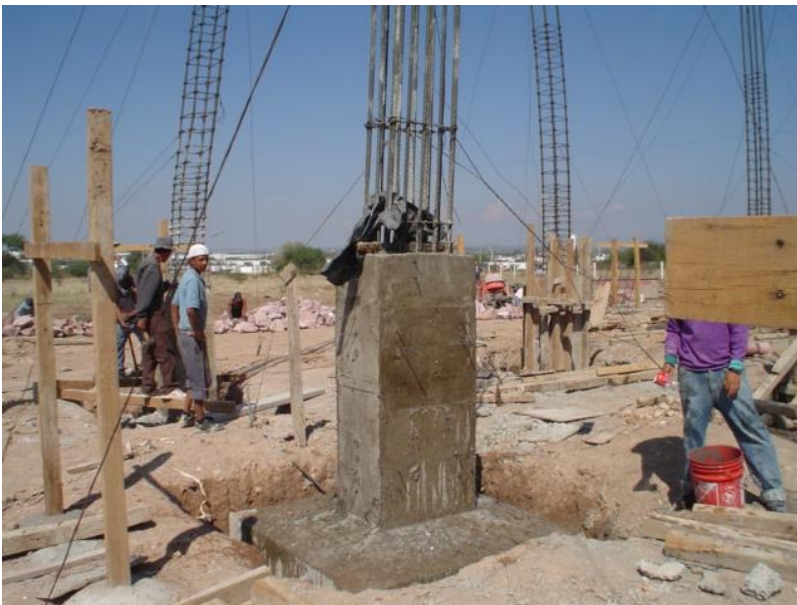
Revisión de zapatas y dados
