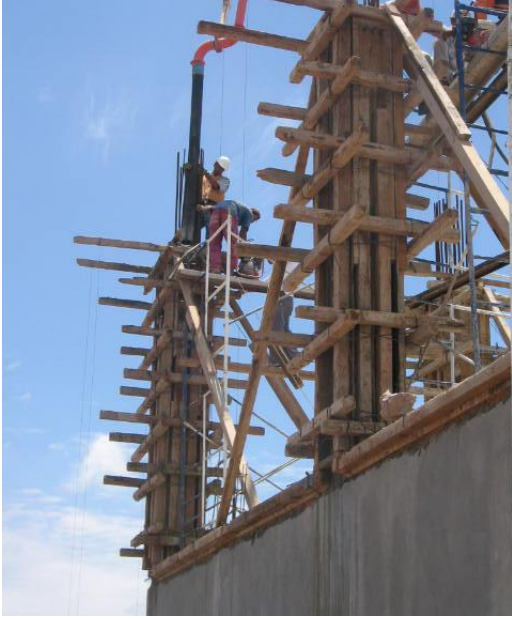
Supervisión de colado de columnas
