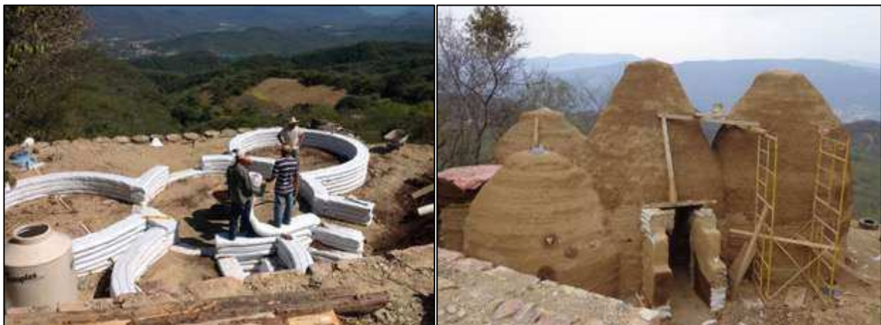
Figura 59. Construcción de super adobe ( (fuente: elaboración propia)
