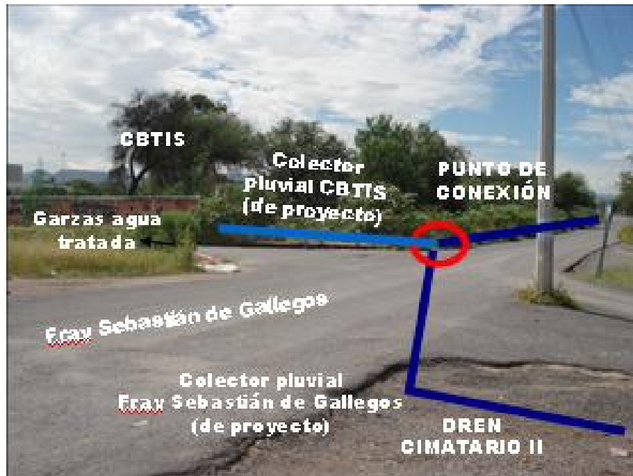
Fotografía 20.- Punto de conexión del colector Fray Sebastián de Gallegos con colector CBTIS
