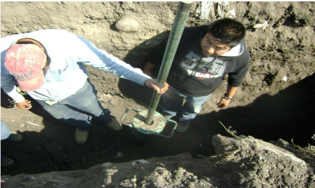
Figura 28.- Se muestra el momento de realizar el ensaye de Penetración Estándar a la profundidad de 3.10 m. del sondeo No. 1.
