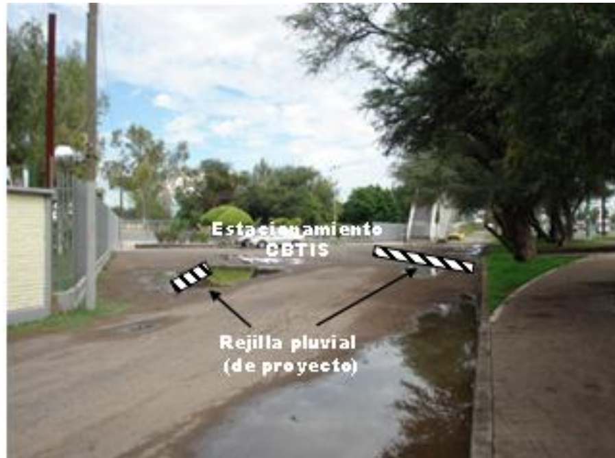
Figura 15.- Rejillas pluviales de proyecto en el estacionamiento del CBTIS
