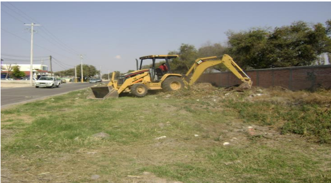
Figura 35.- Una vez concluidos los trabajos de exploración y muestreo de cada uno de los sondeos realizados, se procedió a tapar los pozos con máquina retroexcavadora
