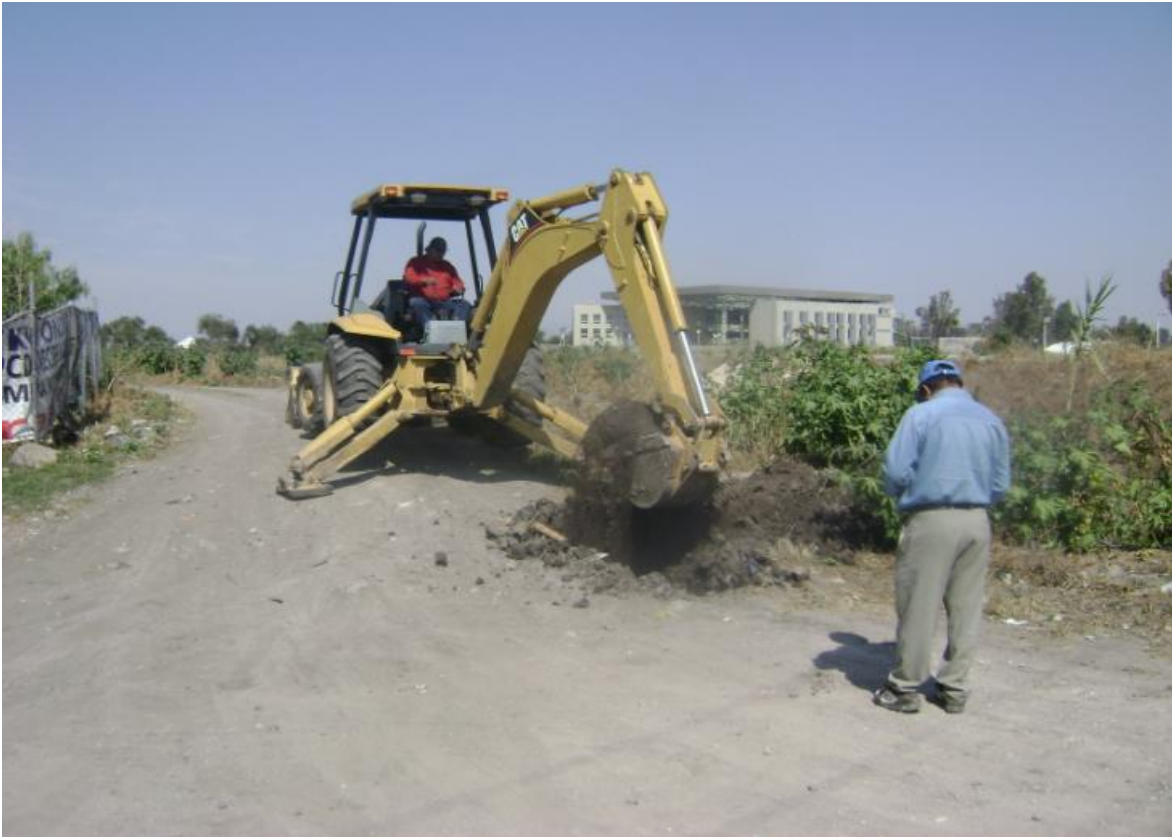
Figura 26.- Muestra el momento de realizar el sondeo No. 1 con máquina retroexcavadora en el hombro del Dren Cimatario II en su intersección con la Calle Fray Sebastián de Gallegos
