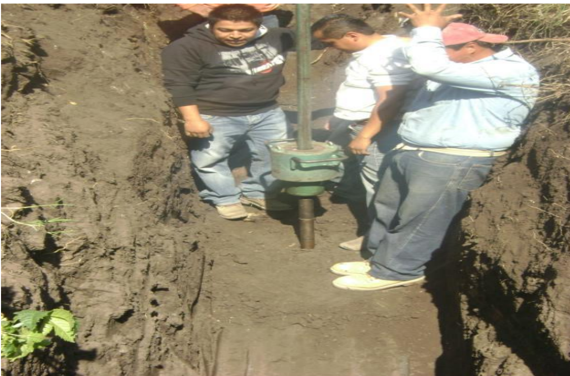
Figura 30.- Ensayo de Penetración Estándar en el sondeo No.2 a la profundidad que por proyecto se debe colocar la tubería del colector pluvial.
