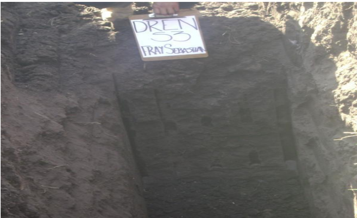
Figura 32.- Muestra el sondeo No. 3 realizado con máquina retroexcavadora. Se aprecia el estrato de arcilla inorgánica color café oscuro de consistencia media a firme.
