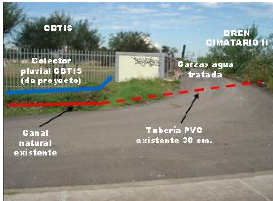
Figura 19.-Canal pluvial natural existente conectado al Dren Cimatarario II con tubería de 30 cm. de PVC
