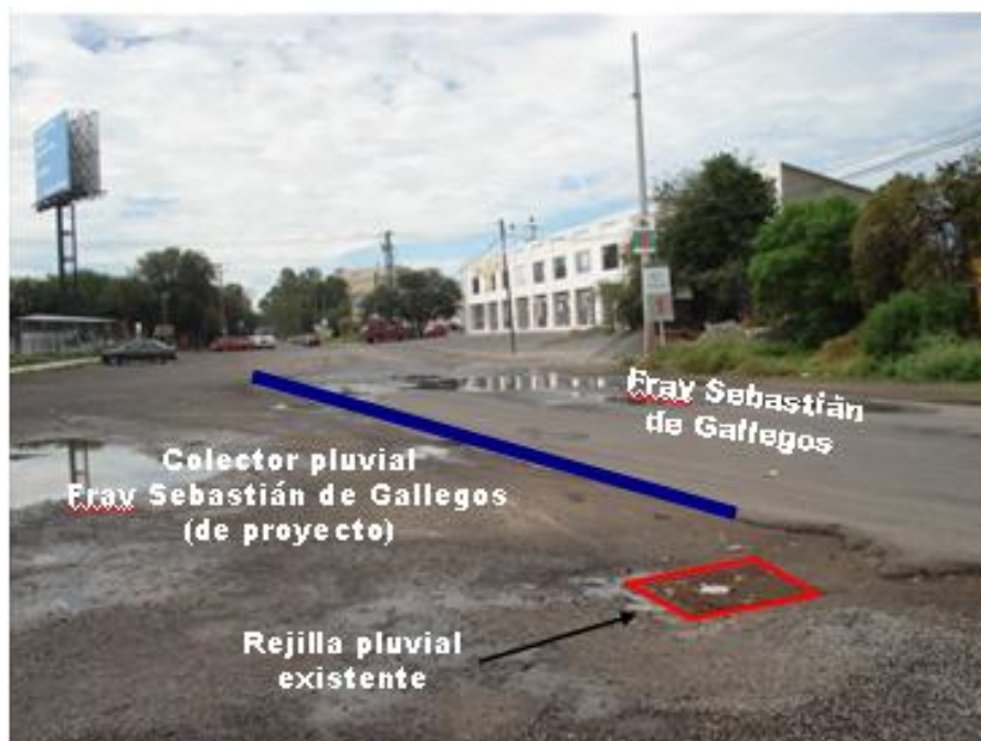
Figura 8.- Rejilla pluvial existente sobre calle Fray Sebastián de Gallegos
