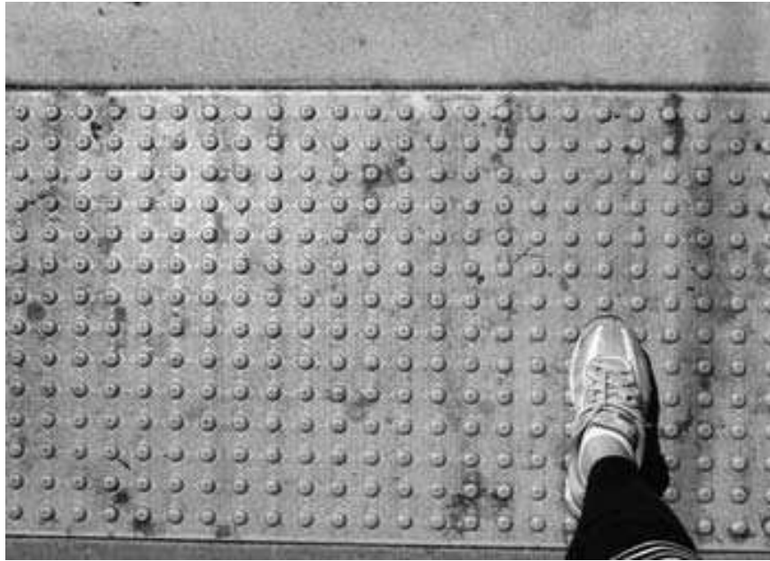
Figura 119. Textura de alerta de 80 cm de profundidad para avisar cambio de nivel e inicio de rampa. San Francisco, EE.UU. Ciudades y espacios para todos. 2010
