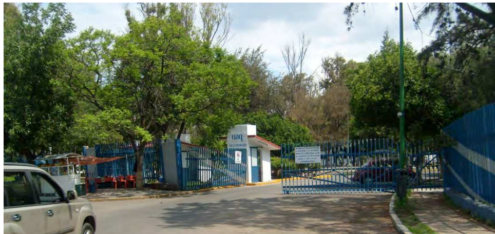
Figura 70. Acceso circuito Universitario. Elaboración propia. 2011.
