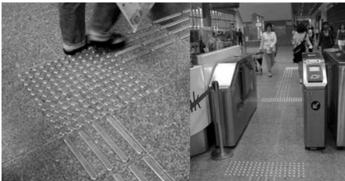
Figura 110. Buena implementación de pavimento táctil. Ciudades y espacios para todos. 2010
