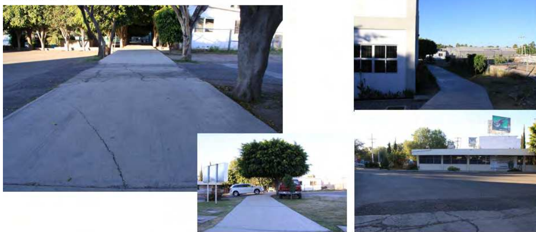
Figura 81. Vías peatonales en diferentes puntos del CU. Elaboración propia. 2011.
