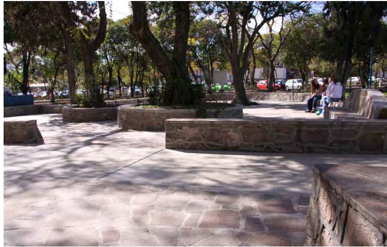
Figura 86. Plaza Facultad de Contaduría y Administración. Elaboración propia. 2011.
