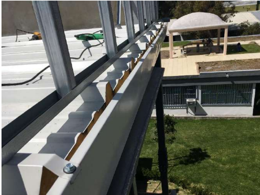
FIGURA 37. Anclaje de pretilas en azotea (Foto tomada por el autor).
