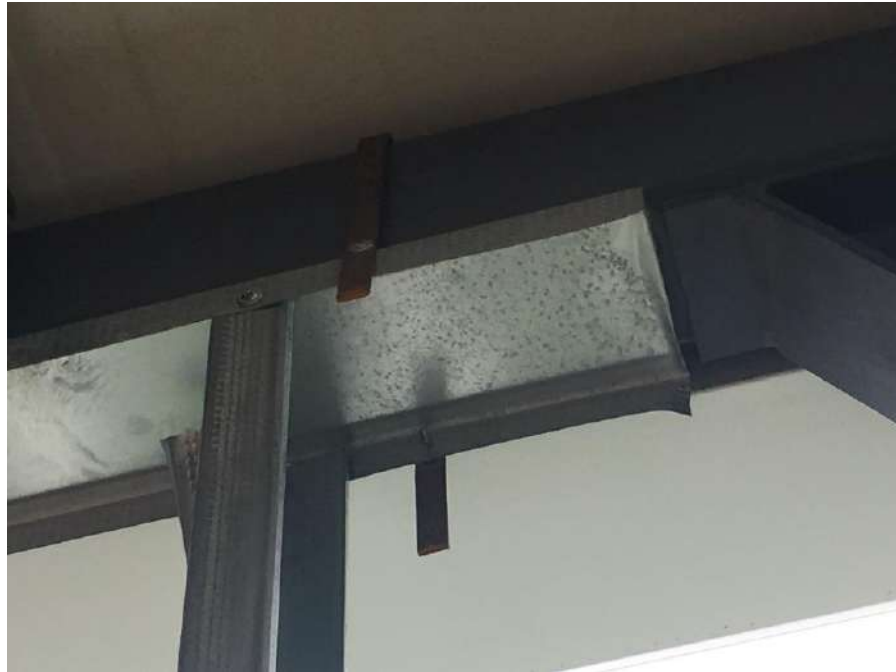
FIGURA 39. Abrazaderas de anclaje en estructura base (Foto tomada por el autor).
