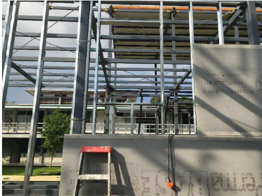
FIGURA 35. Montaje de suspensión para muro prefabricado (Foto tomada por el autor).
