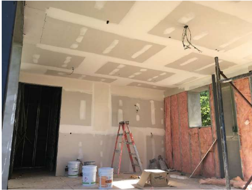
FIGURA 36. Habilitado de muros interiores (Foto tomada por el autor).
