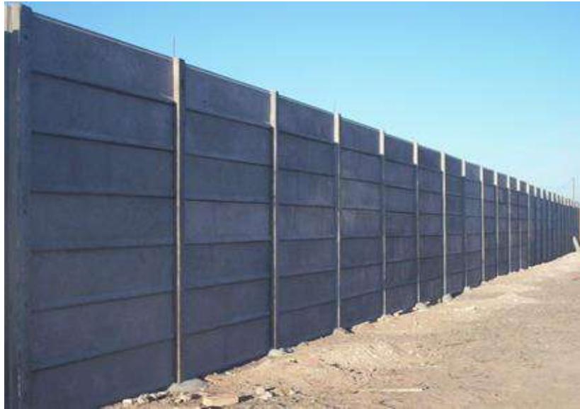
FIGURA 16. Muro premoldeados de concreto armado. (FORTÍN, 2016)
