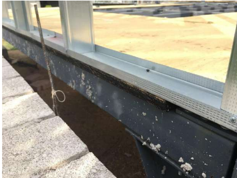
FIGURA 40. Anclaje de muro prefabricado en firme de vivienda (Foto tomada por el autor).
