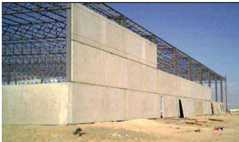
FIGURA 17. Muro prefabricado con panel de concreto ligero. (ARQUIGRÁFICO, 2015).
