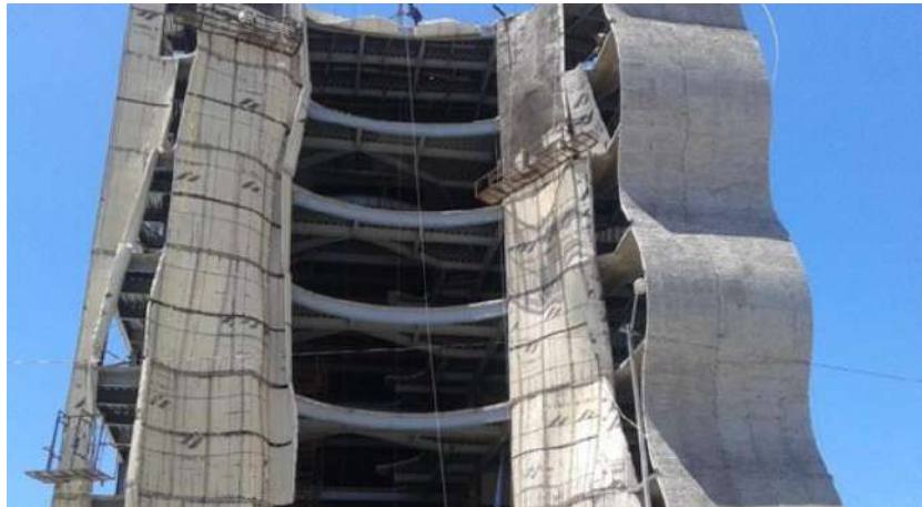
FIGURA 20. Sistema de muros modulares Panel W*. (W, 2015)
