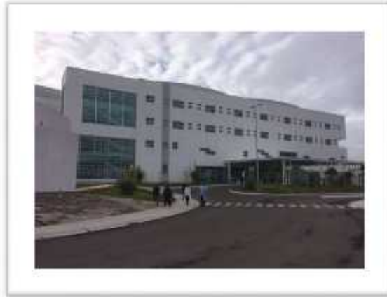
Foto: Del Hospital General de San Juan del Río, Qro
