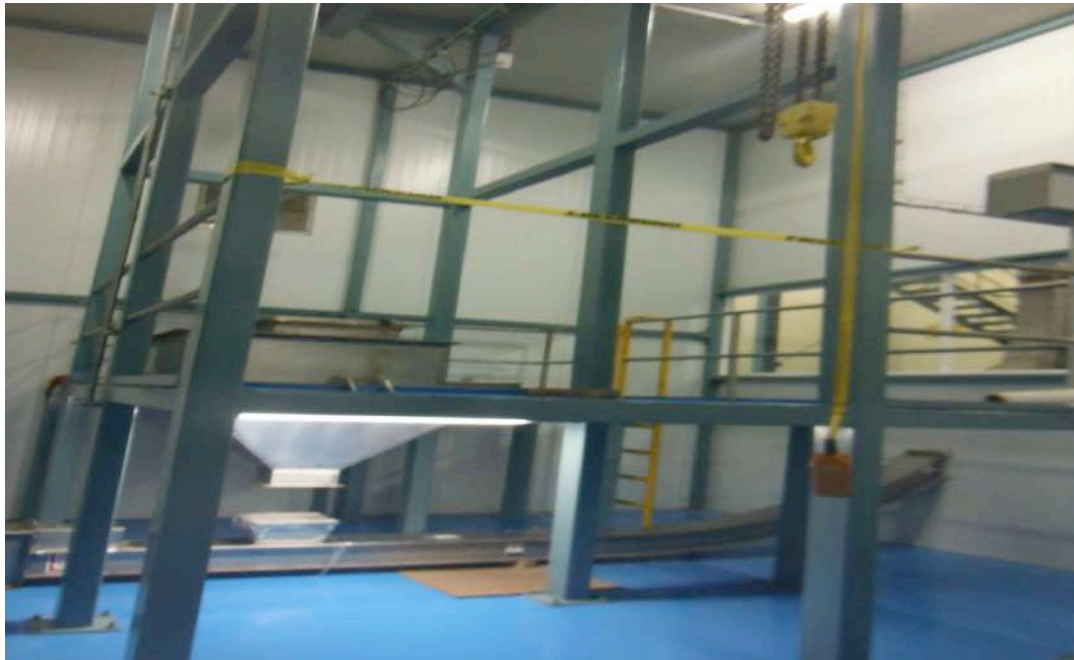
Figura 4.18 Área de vaciado de materia prima
