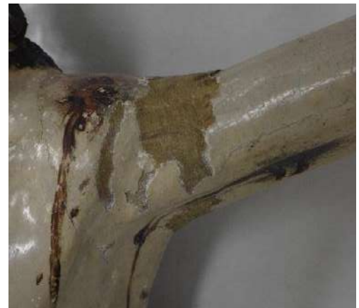
Figura 29 Deterioro anverso del brazo derecho.
