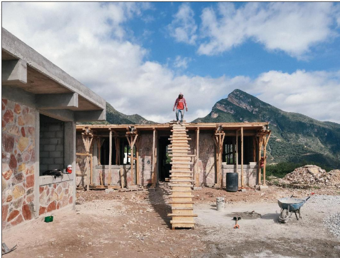
FIGURA 11. CIAC DURANTE SU CONSTRUCCIÓN 16
