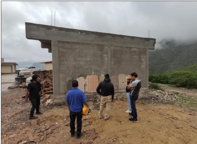
FIGURA 19. PRUEBA DE ACABADOS DURANTE LA OBRA 24
