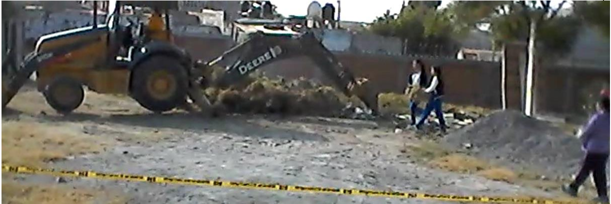
Figura 52 Aquí vemos a la máquina excavadora que retira los escombros y basura mientras las alumnas se acercan para depositar la basura.
