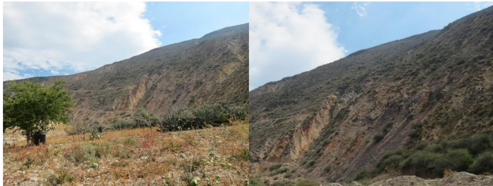
g) Erosión Hídrica por movimiento de masas (Wm), colapso de materiales
