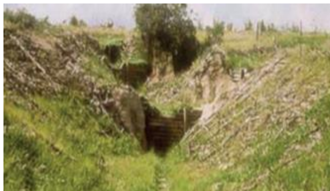
Figura 19. Suavizado de taludes
