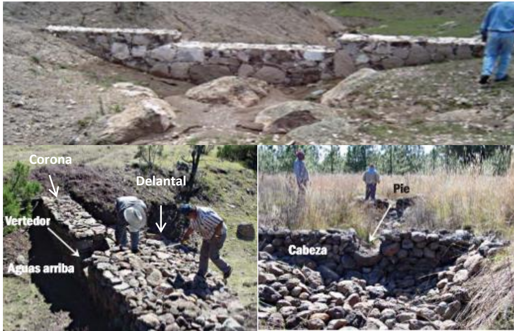
Figura 20. Presas de piedra acomodada.
