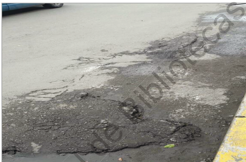
Figura 2.6 Protuberancia en pavimento.
