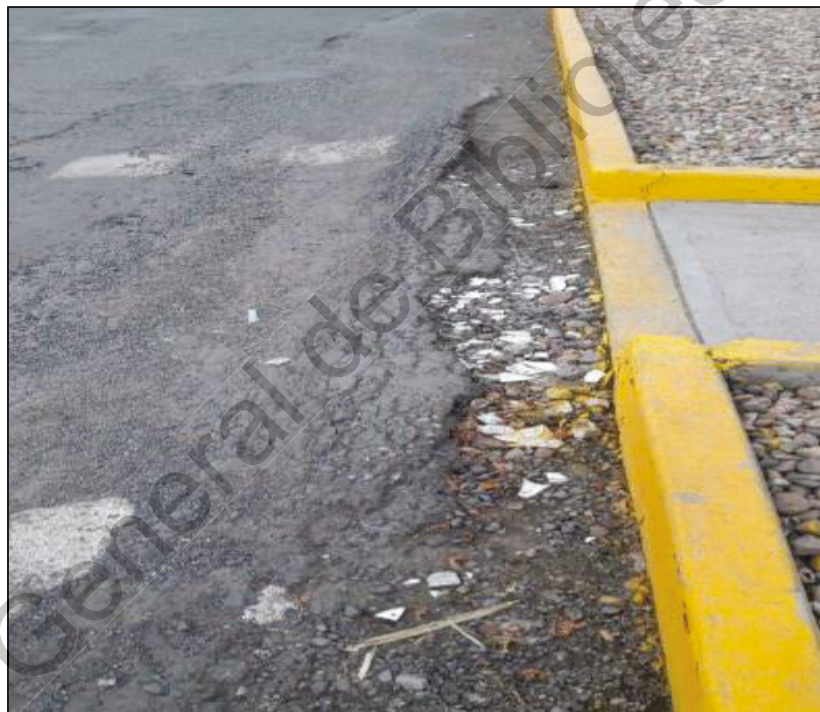
Figura 2.4 Ejemplo de rutting.
