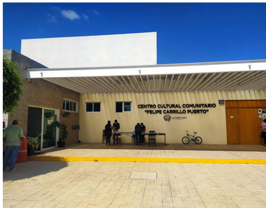
Fig. 51 Centro Cultural Comunitario “Felipe Carrillo Puerto”. Entrada principal (Elaboración propia,2022)
