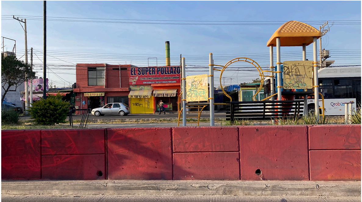
Imagen 8: fotografía tomada desde el paradero Toltecas con dirección hacia el Cerro del Tambor en el Eje Avenida de la Luz; se ve en primer plano el muro que divide el carril confinado con el área de juegos infantiles en el parque lineal; un poco atrás, en el carril del sentido contrario del lado izquierdo, se alcanza a ver a una unidad de transporte público; al fondo, algunas viviendas y negocios locales. Fuente: archivo personal, 2021.
