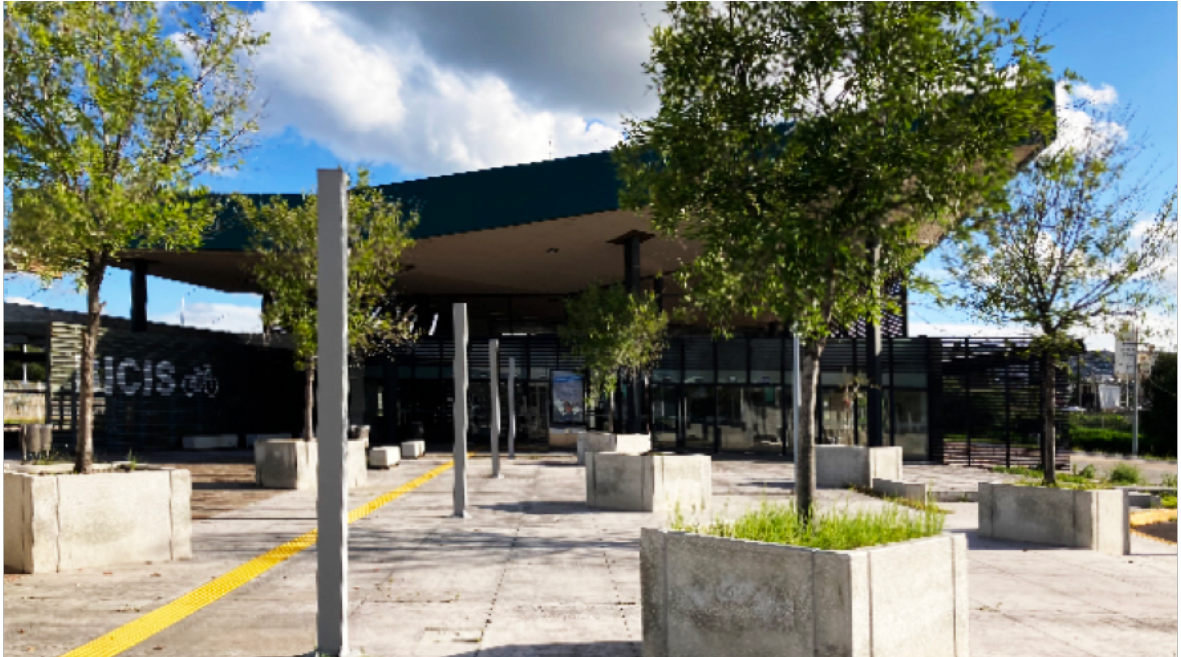
Imagen 5: vista exterior de la Estación Regional Balvanera; en el costado izquierdo de la imagen puede observarse la zona delimitada para guardar las bicicletas; el estilo arquitectónico de la construcción se asemeja al de los paraderos laterales y las estaciones centrales, por ejemplo, las bancas de concreto que se observan situadas a un costado de la entrada principal. Fuente: archivo personal, 2021.
