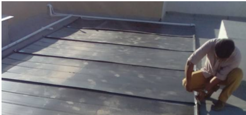
Figura 46. Instalación de paneles solares. Fuente: archivos internos de la organización (2020).
