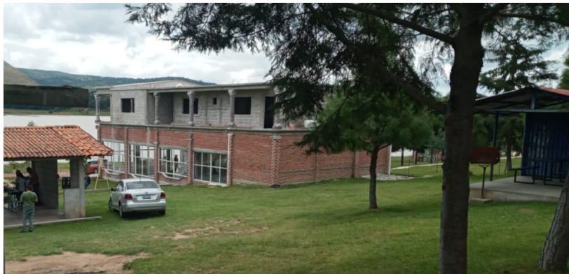
Figura 63. Restaurante y hotel en construcción. Fuente: elaboración propia (2020).
