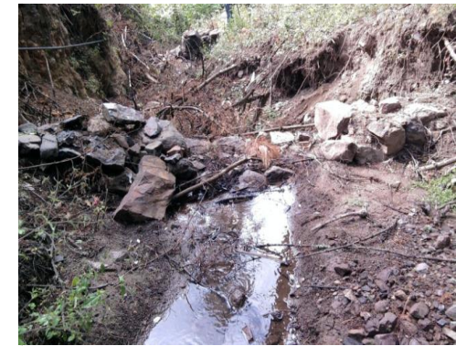
Vista hacia aguas arriba en la evaluación
