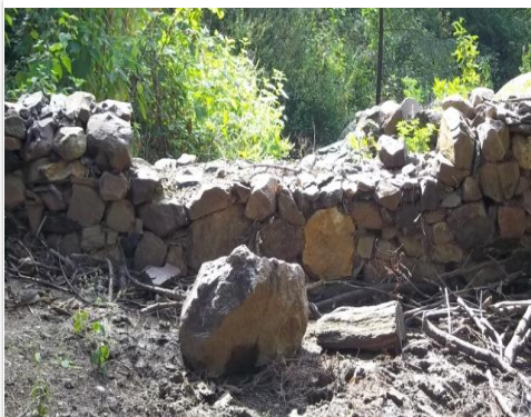
Vista hacia aguas arriba en la evaluación
