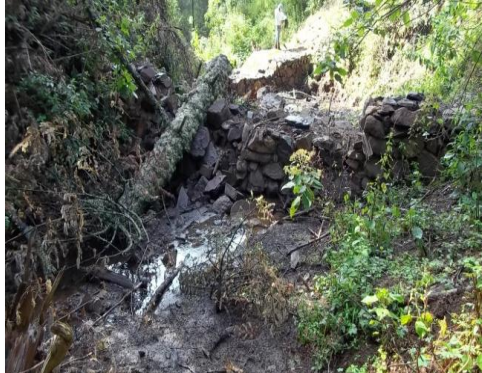
Vista hacia aguas arriba en la evaluación
