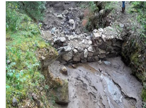
Vista hacia aguas arriba en la evaluación
