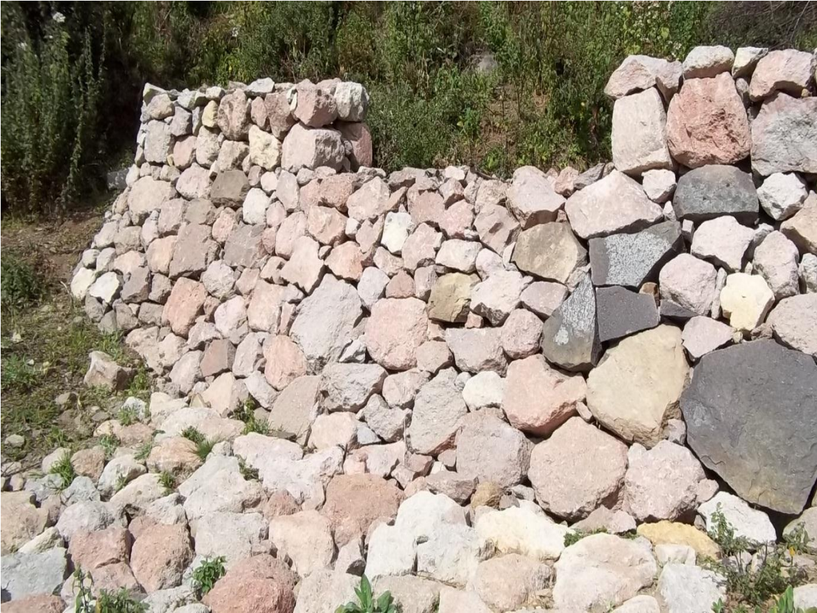
Figura 18. Estructura de piedra acomodada
