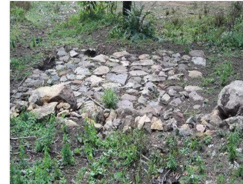
Vista hacia aguas arriba en la evaluación
