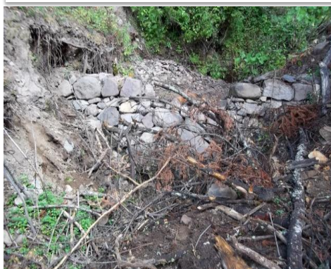
Vista hacia aguas abajo en la evaluación
