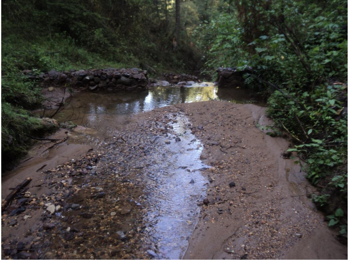
Figura 29. Presa de piedra acomodada
