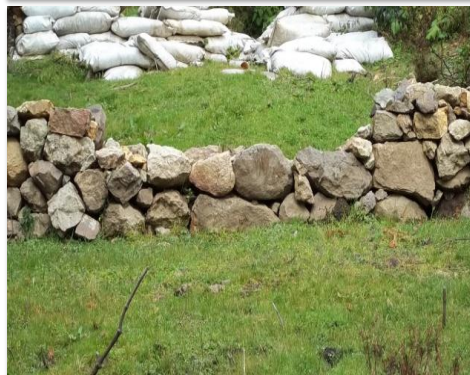
Vista hacia aguas abajo en la evaluación
