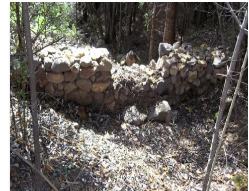
Vista hacia aguas arriba en la evaluación
