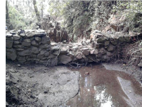
Vista hacia aguas arriba en la evaluación
