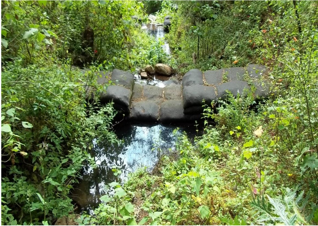
Figura 27. Presa de geocostales
