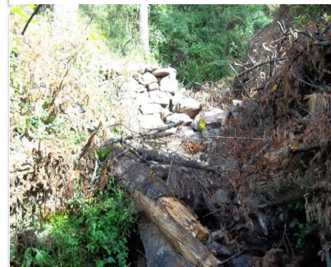
Vista hacia aguas abajo en la evaluación
