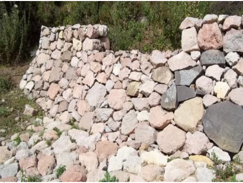
Vista hacia aguas abajo en la evaluación
