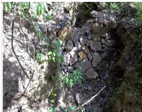
Vista hacia aguas abajo en la evaluación
