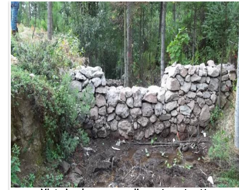
Vista hacia aguas arriba en la evaluación
