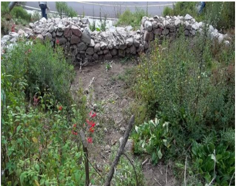
Vista hacia aguas arriba en la evaluación
