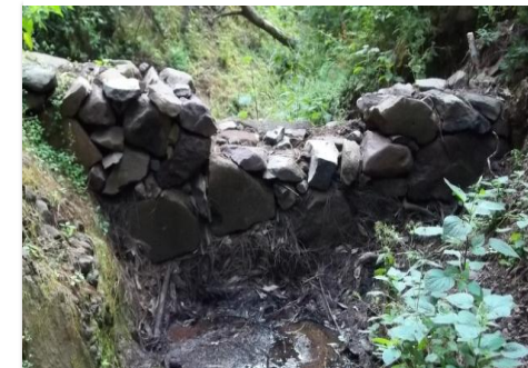
Vista hacia aguas arriba en la evaluación
