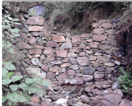
Vista hacia aguas abajo en la evaluación
