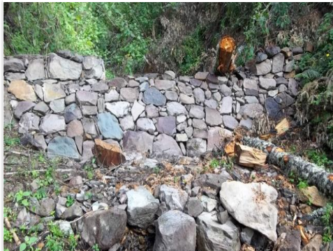
Vista hacia aguas abajo en la evaluación
