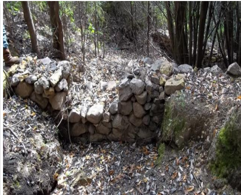
Vista hacia aguas arriba en la evaluación
