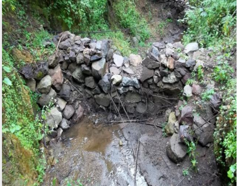
Vista hacia aguas arriba en la evaluación
