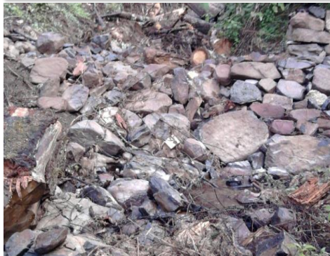
Vista hacia aguas abajo en la evaluación
