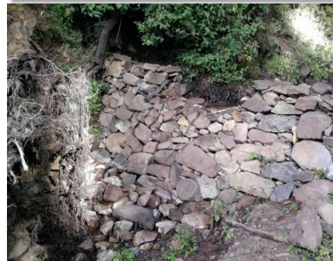
Vista hacia aguas abajo en la evaluación
