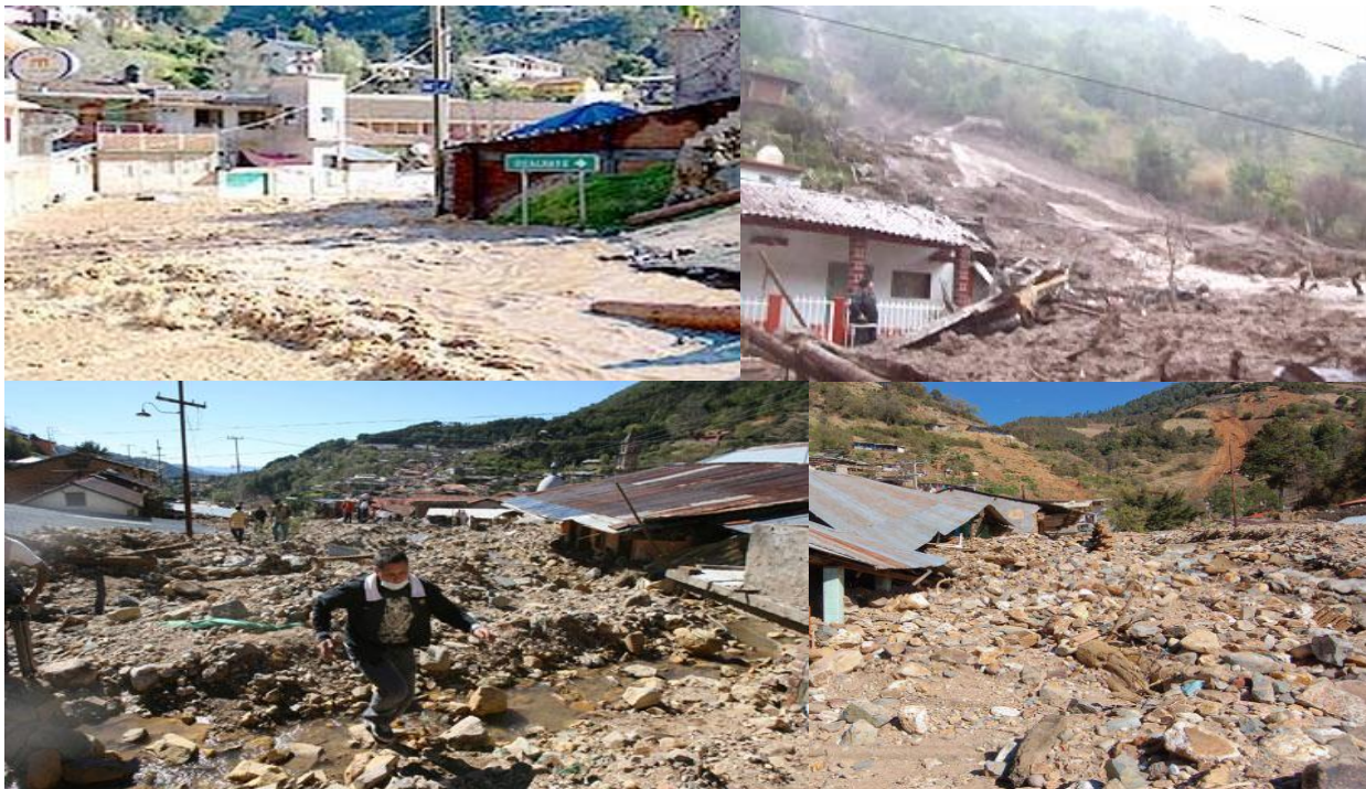
Figura 20. Casas destruidas por la tormenta
