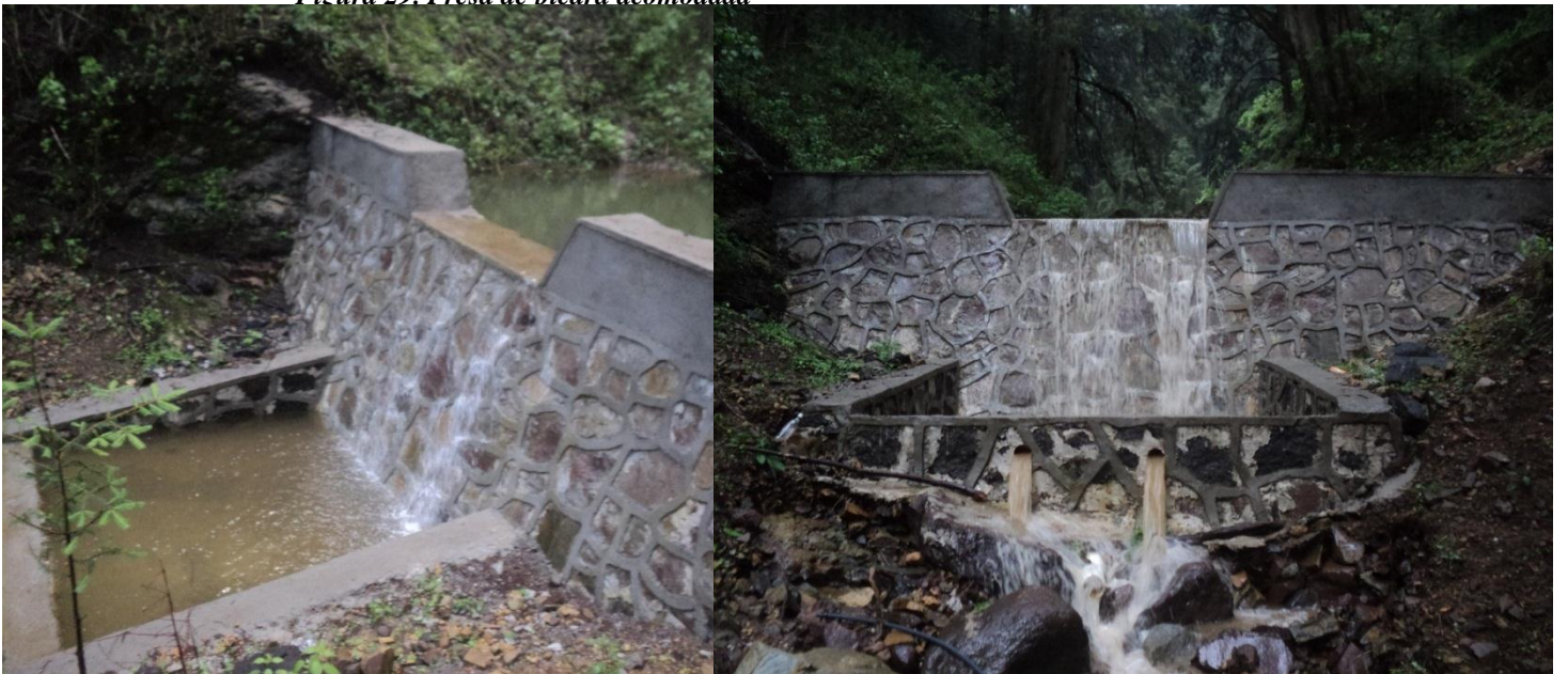
Figura 30. Presa de mampostería (dos vistas)
