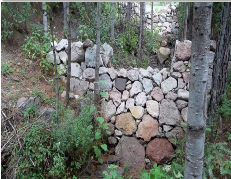
Vista hacia aguas abajo en la evaluación
