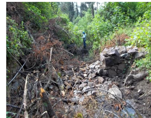
Vista hacia aguas arriba en la evaluación
