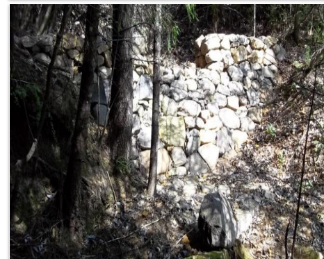
Vista hacia aguas abajo en la evaluación
