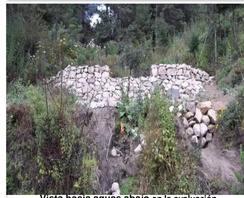
Vista hacia aguas abajo en la evaluación
