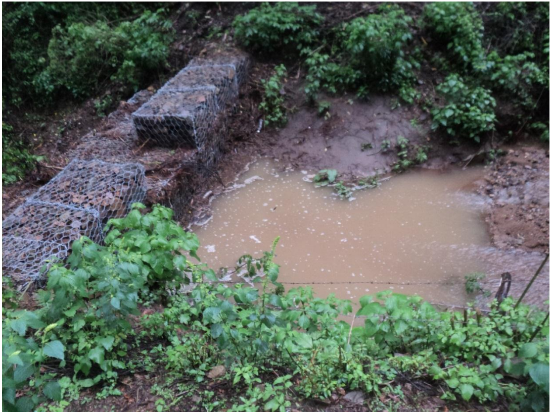
Figura 28. Presa de gavi3n
