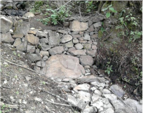
Vista hacia aguas abajo en la evaluación
