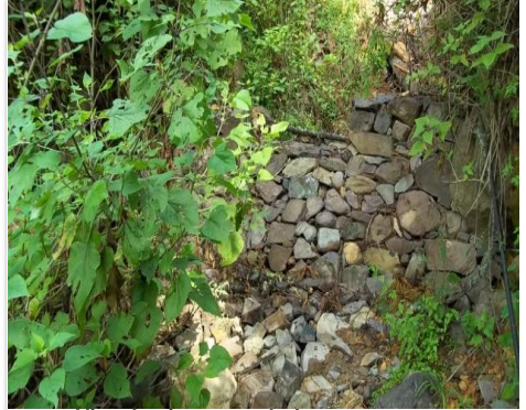
Vista hacia aguas abajo en la evaluación
