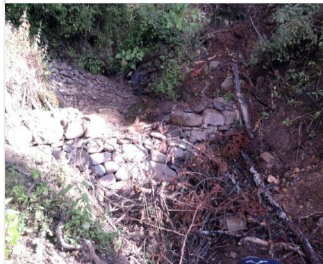
Vista hacia aguas abajo en la evaluación
