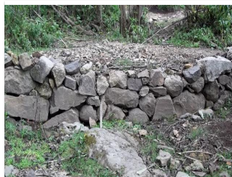
Vista hacia aguas abajo en la evaluación
