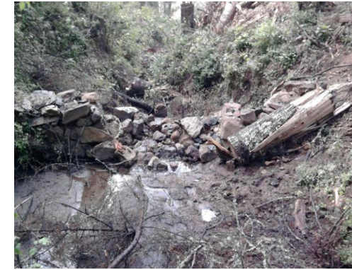
Vista hacia aguas arriba en la evaluación
