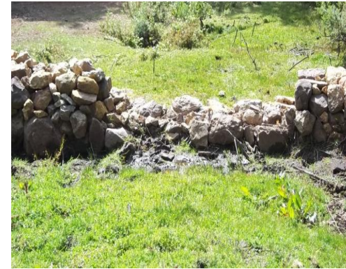
Vista hacia aguas arriba en la evaluación
