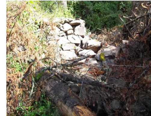
Vista hacia aguas arriba en la evaluación
