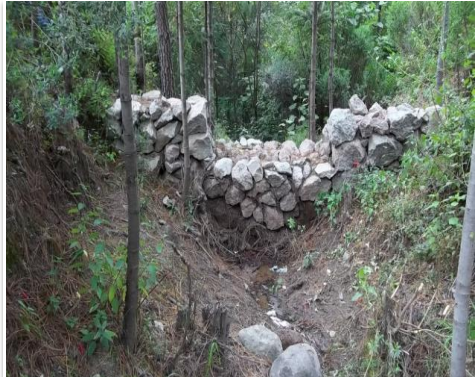
Vista hacia aguas arriba en la evaluación
