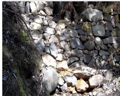
Vista hacia aguas abajo en la evaluación
