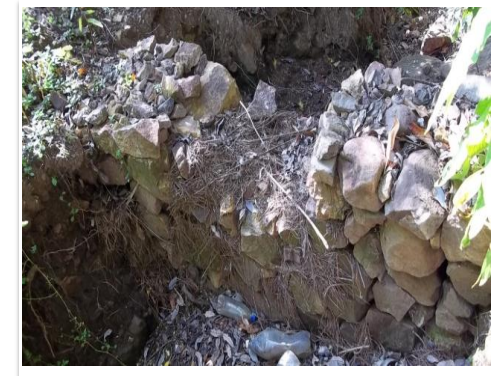
Vista hacia aguas arriba en la evaluación
