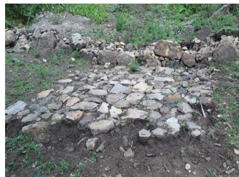
Vista hacia aguas abajo en la evaluación
