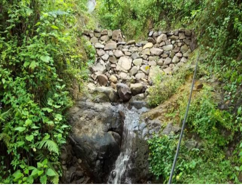
Vista hacia aguas abajo en la evaluación
