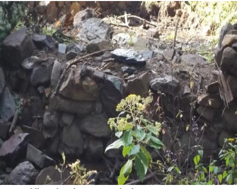
Vista hacia aguas abajo en la evaluación
