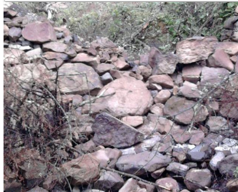
Vista hacia aguas abajo en la evaluación
