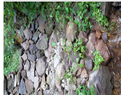
Vista hacia aguas abajo en la evaluación
