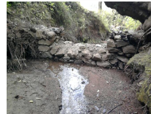
Vista hacia aguas arriba en la evaluación
