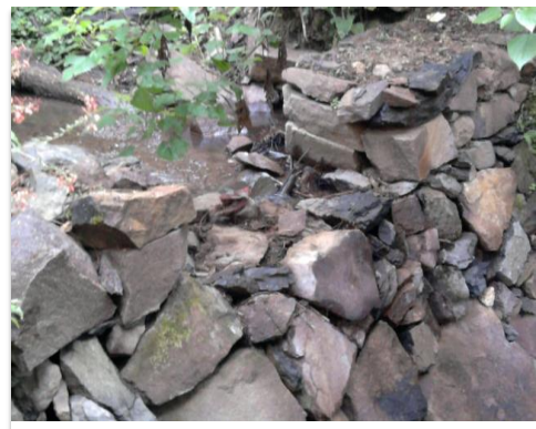
Vista hacia aguas arriba en la evaluación
