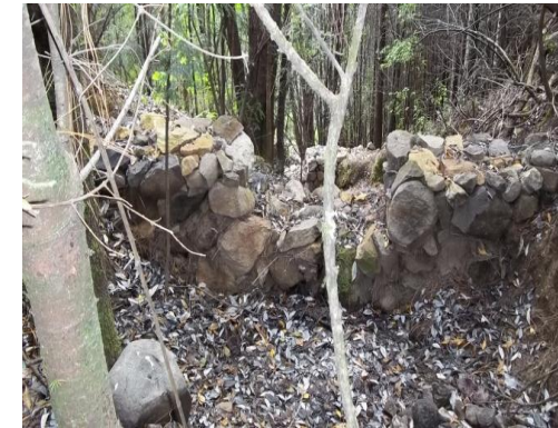
Vista hacia aguas arriba en la evaluación
