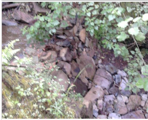
Vista hacia aguas abajo en la evaluación
