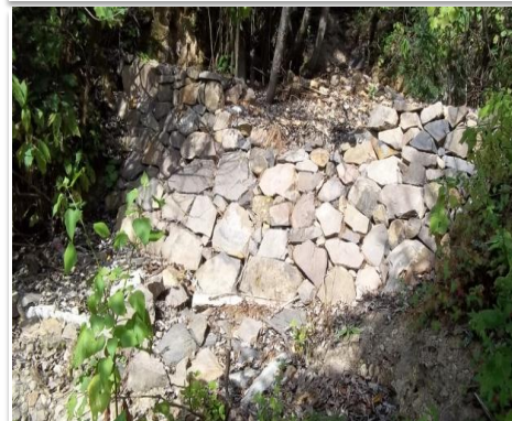
Vista hacia aguas abajo en la evaluación
