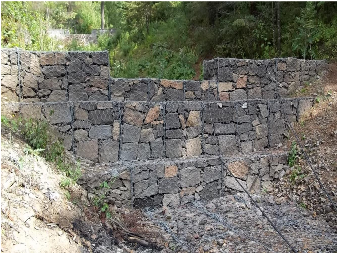
Figura 16. Estructura de gavión
