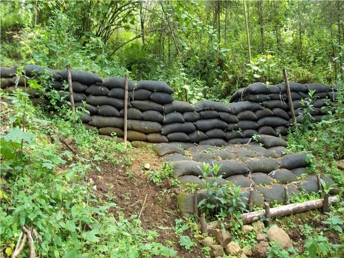
Figura 15. Estructura de geocostales
