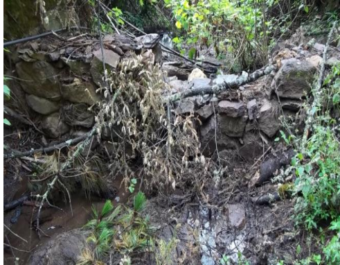
Vista hacia aguas arriba en la evaluación
