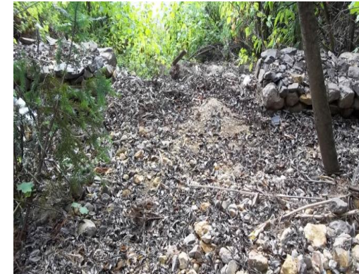
Vista hacia aguas arriba en la evaluación
