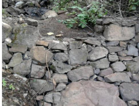
Vista hacia aguas arriba en la evaluación
