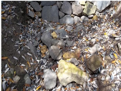
Vista hacia aguas abajo en la evaluación
