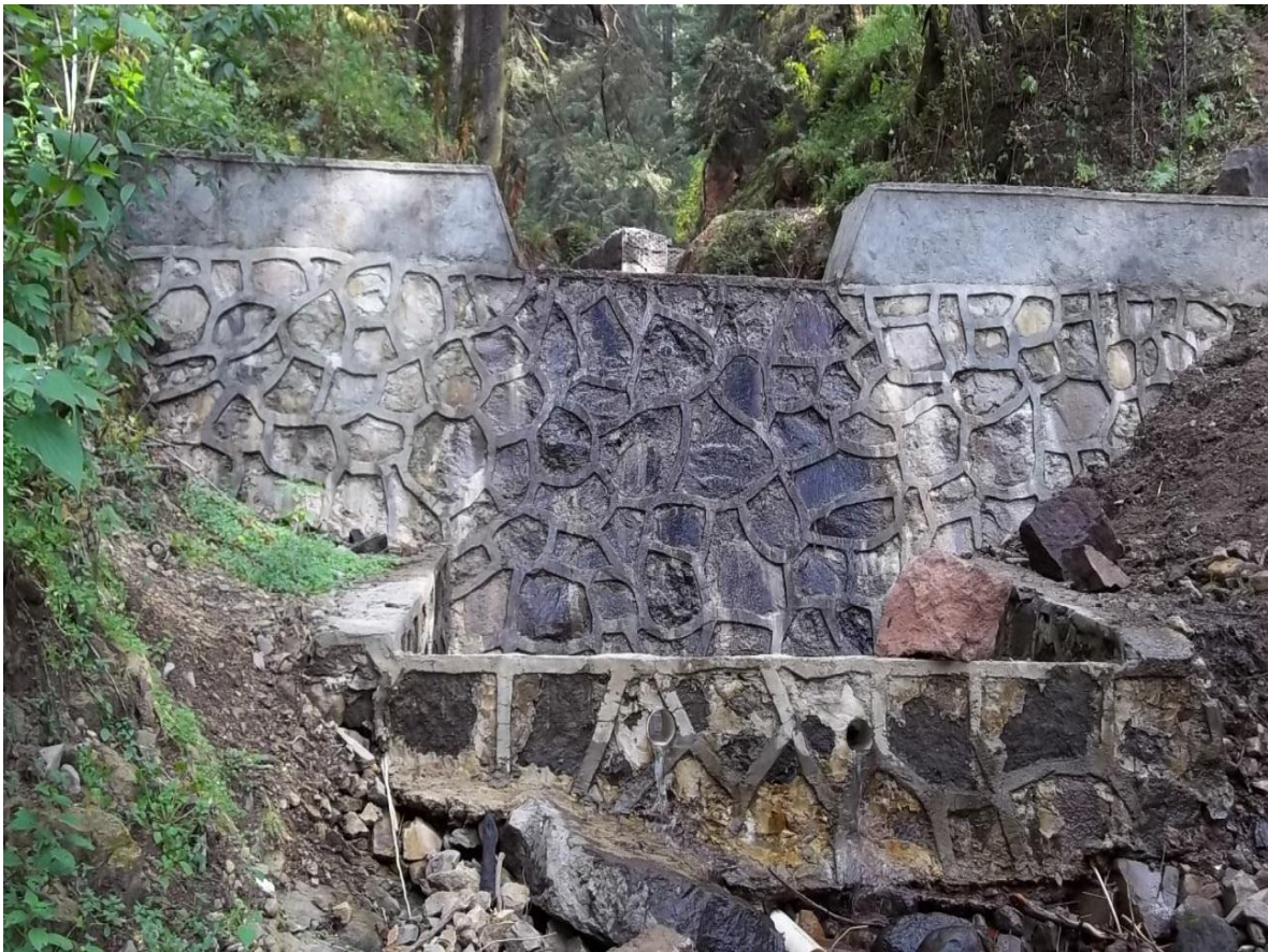
Figura 17. Estructura de mampostería
