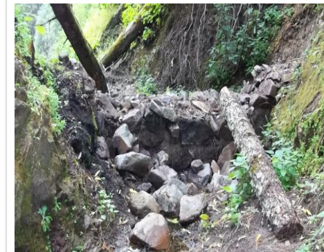
Vista hacia aguas arriba en la evaluación
