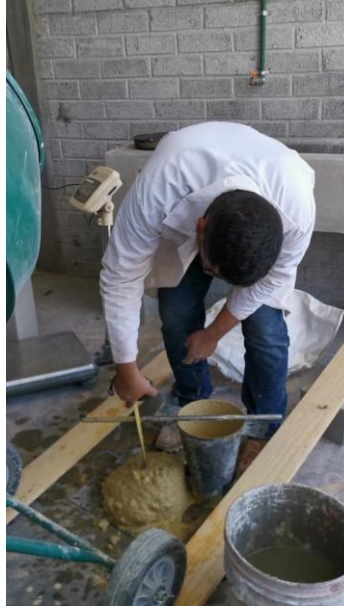
Figura 10. Resultado de prueba de revenimiento en mezclas de concreto
