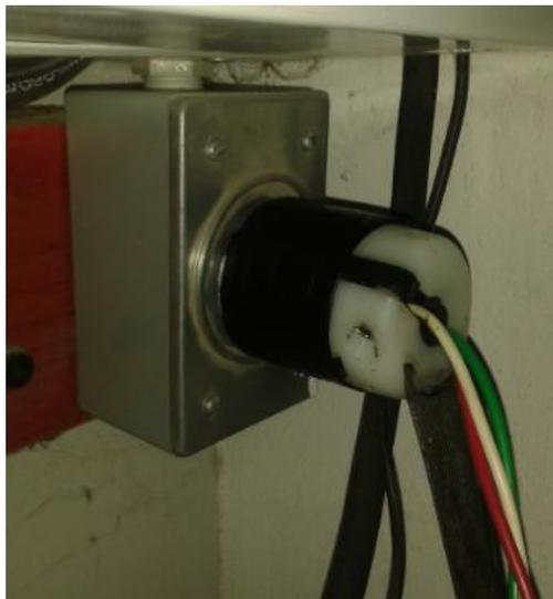
**Figura 4.7.** Enchufe y clavija de seguridad conectada.
