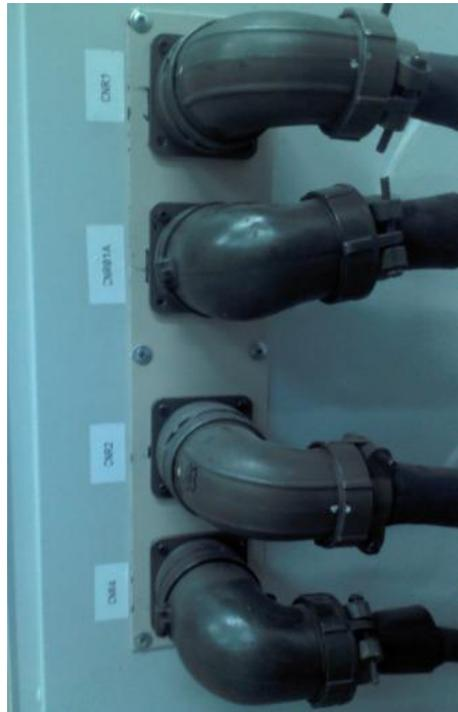
**Figura 4.2.** Conectores tipo J de 45 pines del gabinete de control.
