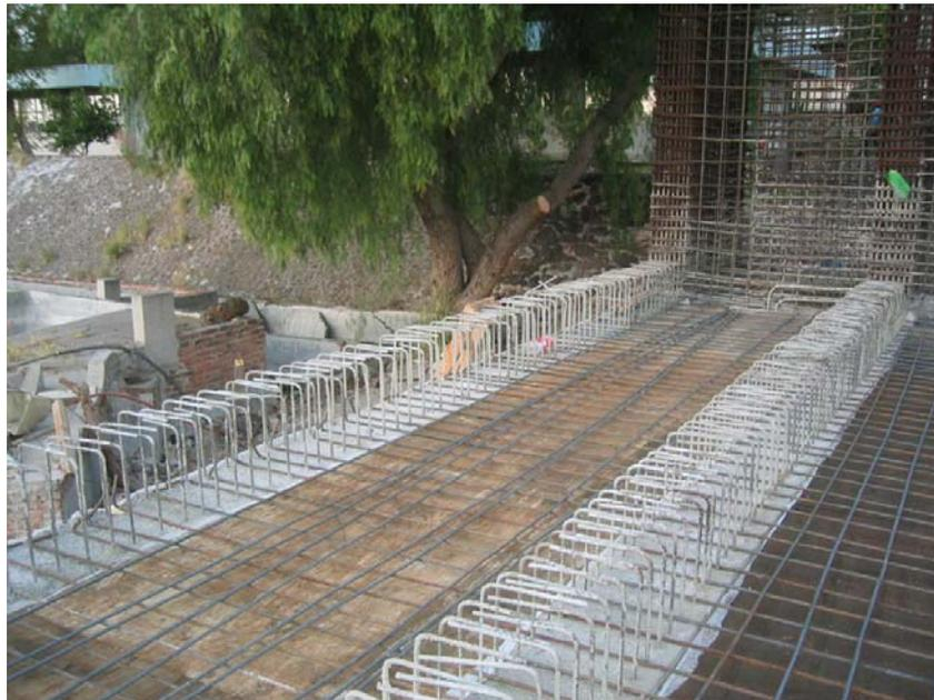
*Figura B.15.- Primera capa de acero de refuerzo de losa de reacción (14 de Diciembre de 2006)*
