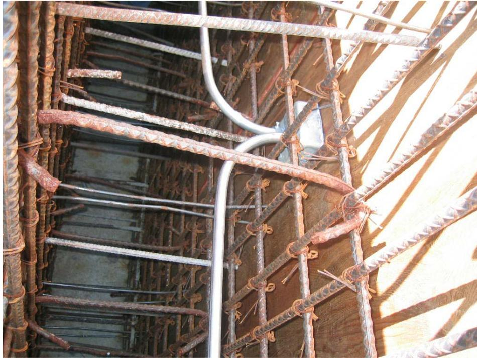
*Figura 6.7.- Muestra la instalación eléctrica ahogada en los muros de sostenimiento.*
