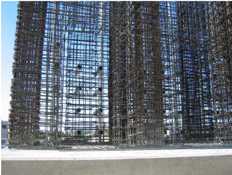
*Figura B.21.- Instalación de agujeros pasantes para el muro de reacción (21 de Enero de 2007)*
