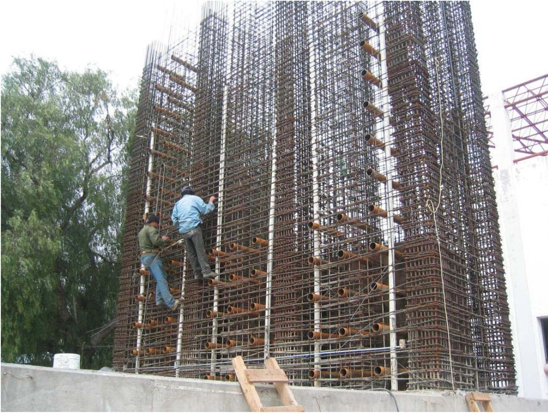
*Figura B.22.- Instalación de agujeros pasantes y tubería para futuro postensado (21 de Enero de 2007)*
