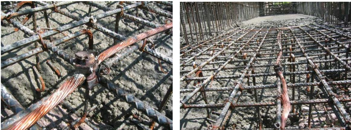
*Figura 6.6.- Tierras físicas para aterrizar el acero de refuerzo.*
