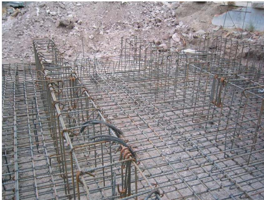
*Figura B.3.- Segunda capa de losa de cimentación y estribos para cortante de muros (22 de Mayo de 2005)*
