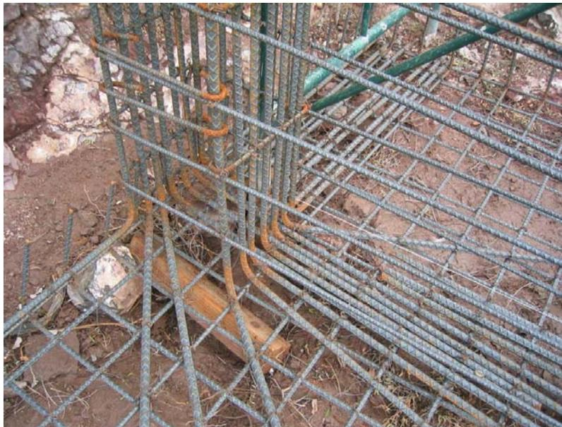
*Figura B. 5.- Armando base para muro de reacción (5 de Julio de 2005)*
