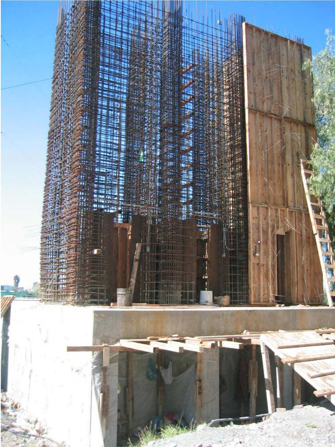
*Figura B.23.- Inicio de cimbrado para colar muro de reacción
