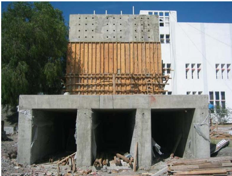
*Figura B.26.- Retiro de cimbra una vez colado el concreto autocompactante
