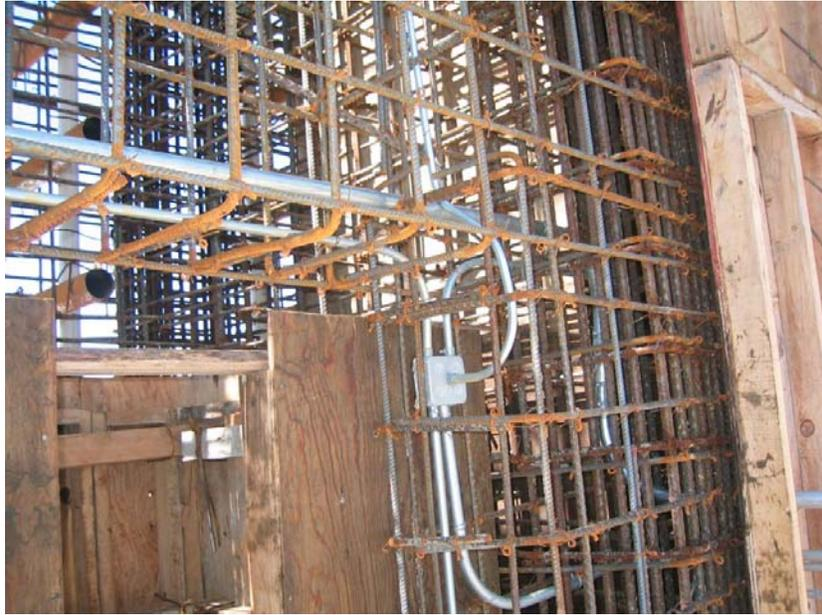
*Figura B.24.- Instalación eléctrica para muro de reacción y tablero de carga principal, parte posterior del muro de reacción. (11 de Febrero de 2007)*
