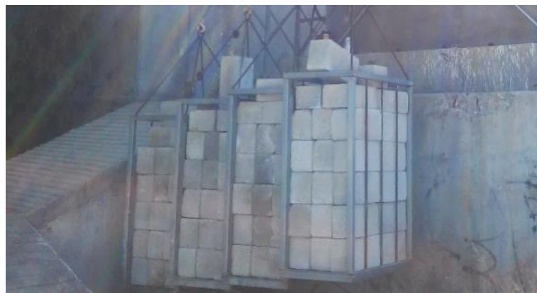
Figura 60. Contrapeso utilizado para aplicación de carga vertical.
