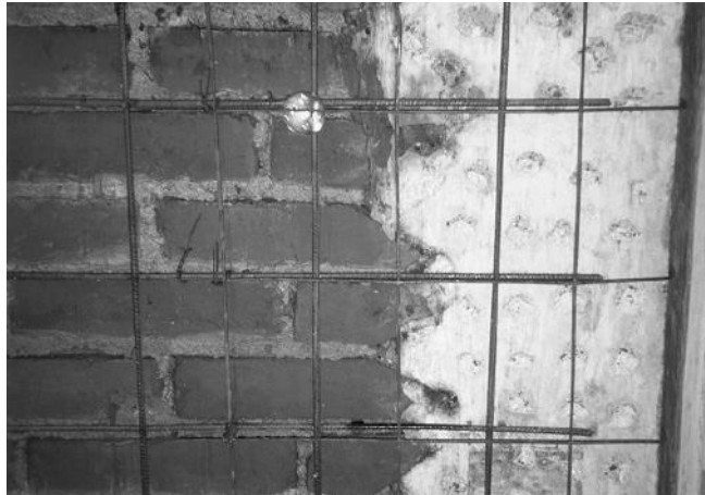
Figura 23. Confinamiento de un castillo con mallas metálicas que han sido traslapadas (Alcocer, 2003).
