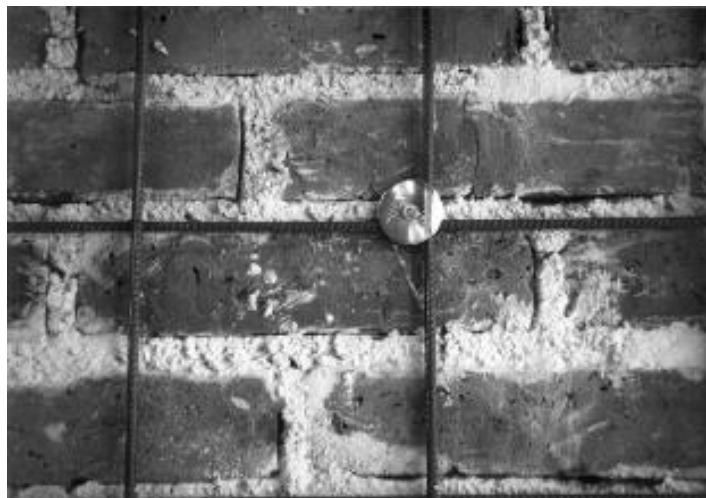
Figura 21. Malla metálica anclada a un muro de mampostería con clavos Hilti (Alcocer, 2003).
