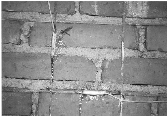
Figura 19. Malla metálica anclada a un muro de mampostería con clavos (Alcocer, 2003).
