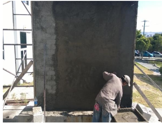
Figura 68. Recubrimiento con mortero en muro rehabilitado construido con tabicón (Romero, 2015).
