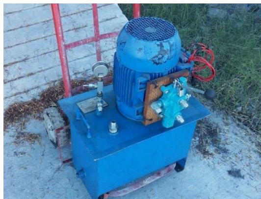
Figura 57. Sistema hidráulico utilizado para aplicación de carga horizontal.
