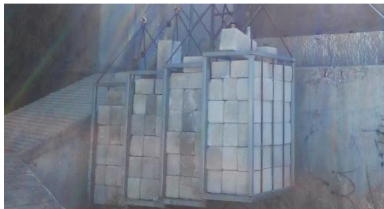
Figura 60. Contrapeso utilizado para aplicación de carga vertical.
