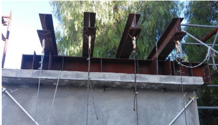
Figura 58. Viga utilizada durante los ciclos de carga.
