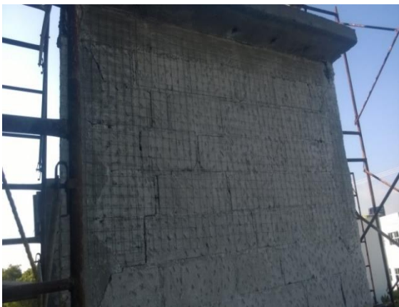
Figura 69. Colocación de multimalla ferretera en muro construido con block de concreto ligero (Romero, 2015).
