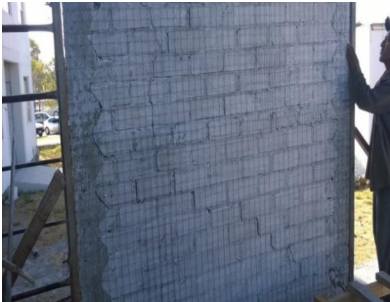
Figura 67. Colocación de multimalla ferretera en muro construido con tabicón (Romero, 2015).
