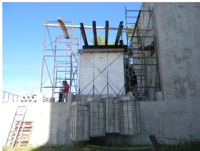
Figura 63. Prueba en muro testigo sin refuerzo construido con piezas de tabicón (Jaen, 2015).
