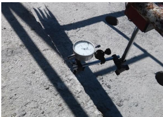
Figura 54. Medición de desplazamientos en la dala de cimentación.
