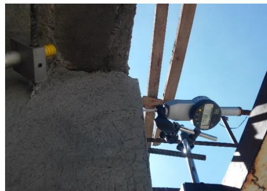
Figura 55. Medición de desplazamientos en la losa.
