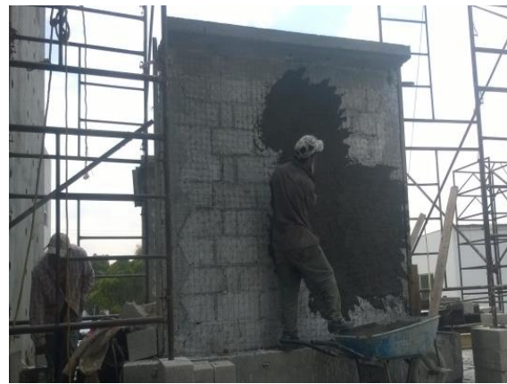
Figura 70. Recubrimiento con mortero en muro rehabilitado construido con block de concreto ligero (Romero, 2015).
