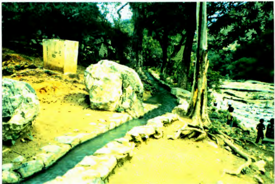
Figura 39. Canal de riego con agua extraída de la mina Plazuela, Peñamiller.
