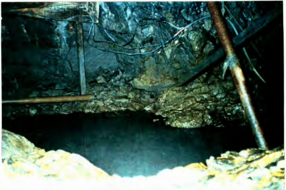
Figura 41. Interior de la mina, donde se aprecia el agua que se bombea hacia el canal de riego, Plazuela, Peñamiller.
