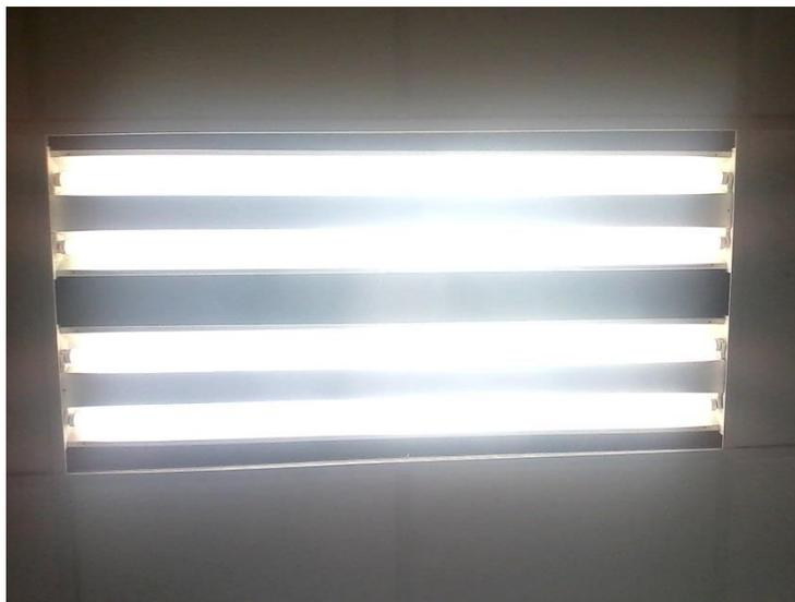
**Figura 3.14.** Lámparas fluorescentes de balastro dimeable.
