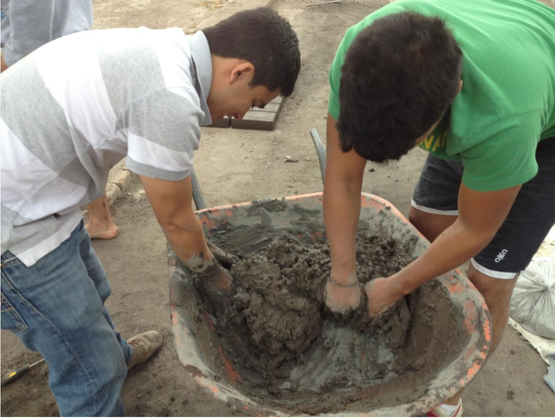
Figura 3.18 Mezclado de Ceniza Volante con mezcla común
