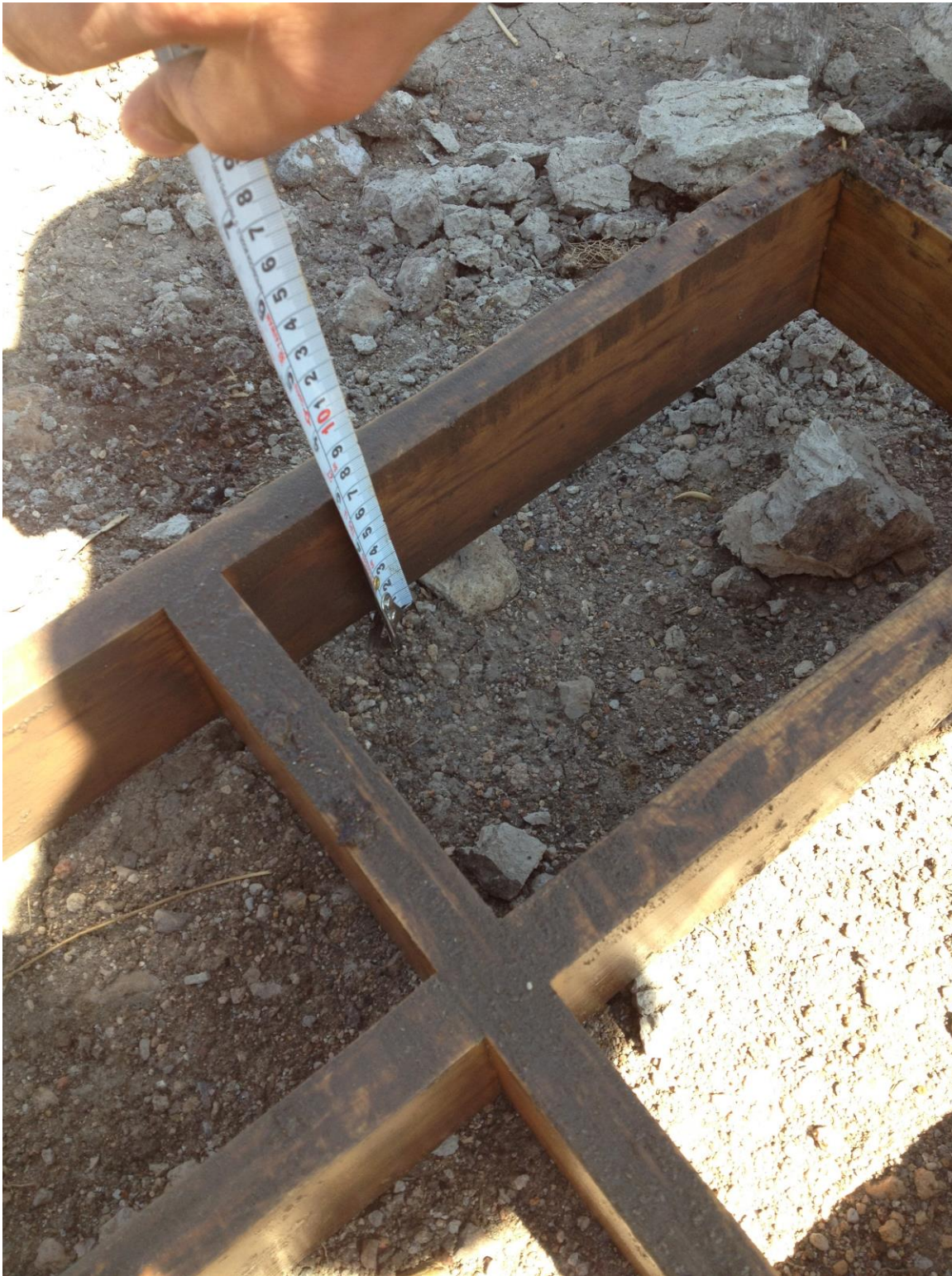
Figura 3.13 Demostración de altura de molde para tabique igual a 7 cm
