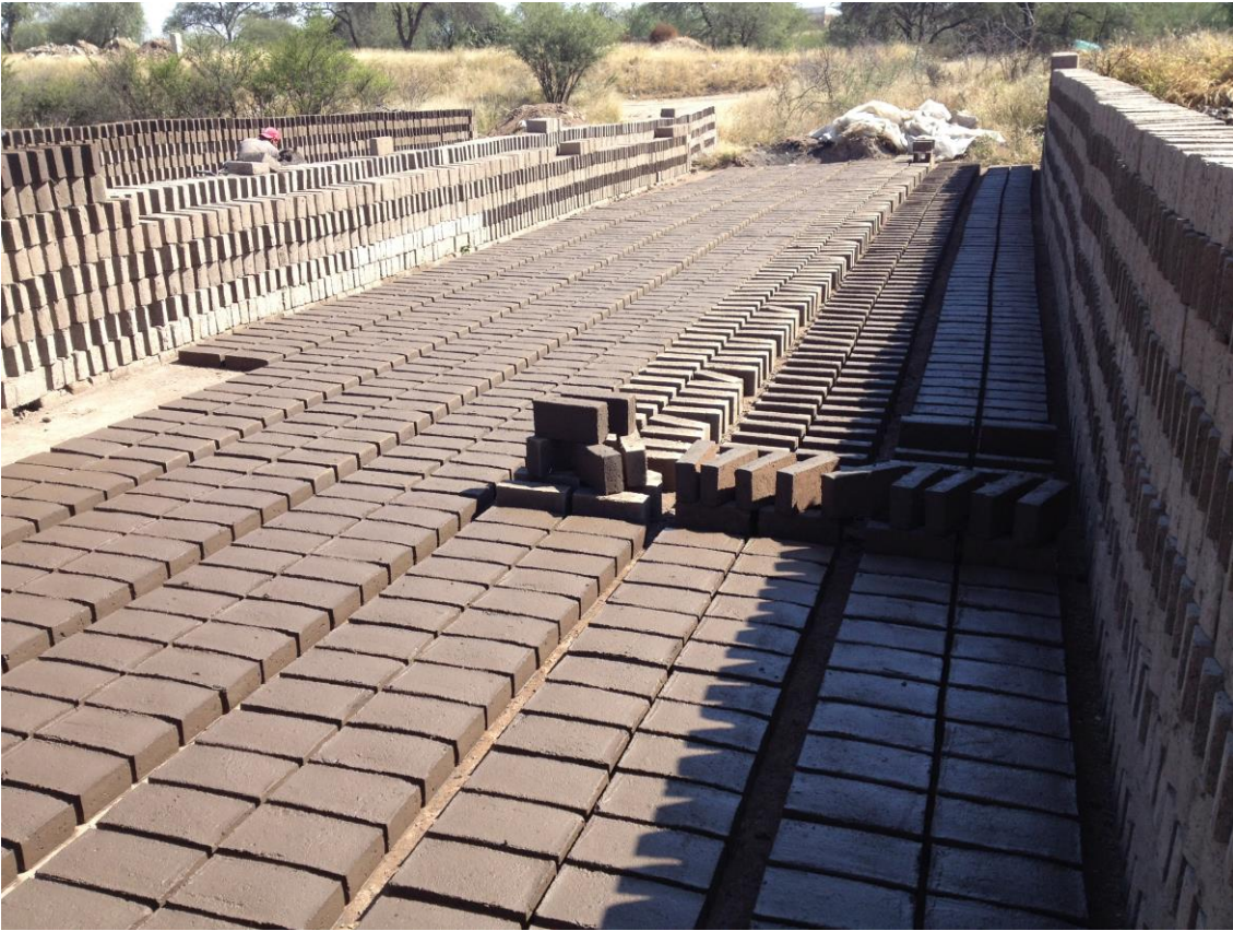
Figura 3.23 Tabiques en proceso de secado
