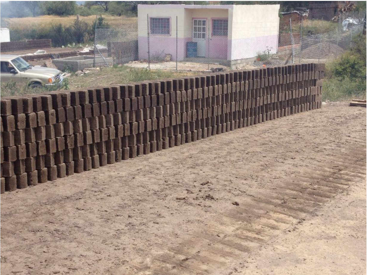
Figura 3.4 Secado de Tabiques
