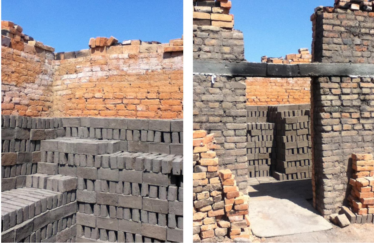
Figura 3.24 Tabiques y particular acomodo dentro del horno
