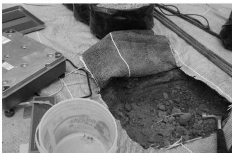
Figura 4.11.- Zanja excavada para colocar la báscula de precisión Avery Weigh-Tronix modelo 3632B-50.
