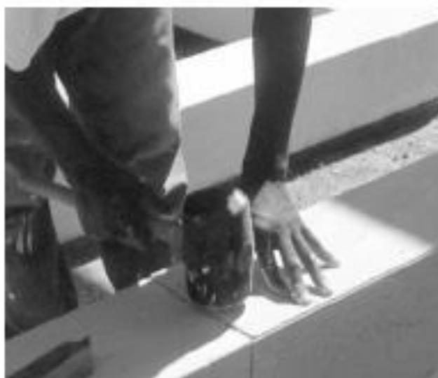
**Figura 13.** Colocación de piezas de mortero celular (HEBEL, 2009).
