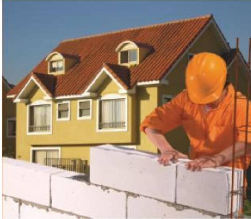
**Figura 11.** Construcción de un muro utilizando bloques de mortero celular HEBEL (HEBEL, 2009)
