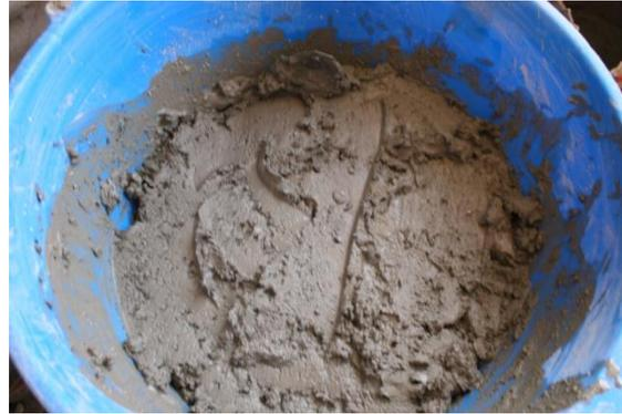
**Figura 41.** Mesclado del cemento y el agua (foto tomada en la UAQ)
