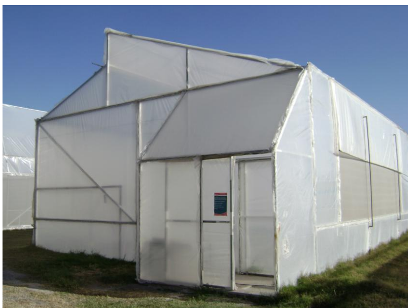
Figura 4.1. Invernadero tipo capilla de 108 m 2 , Campus Amazcala de la Facultad de Ingeniería de la Universidad Autónoma de Querétaro.
