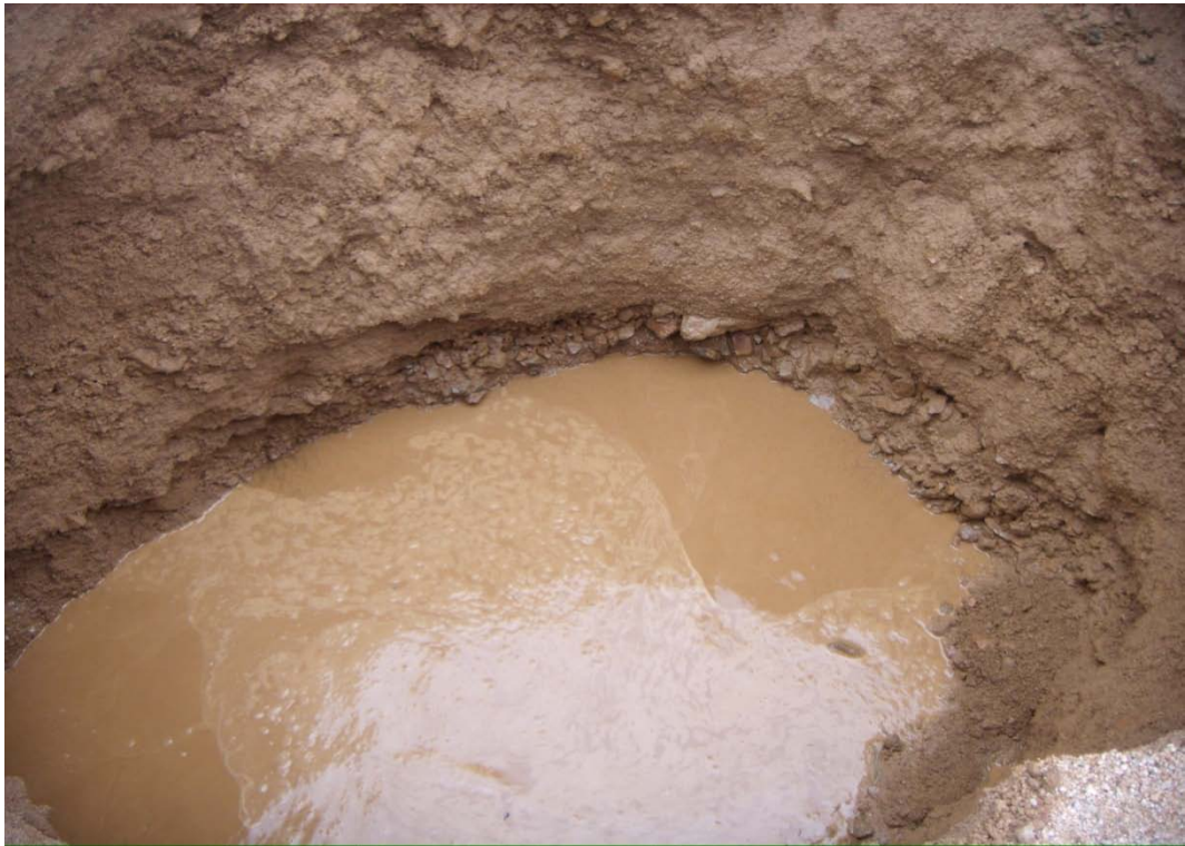
Foto 5.10. Obsérvese pozo a cielo abierto estabilización del nivel freático a una profundidad de 1.50 m. Nótese la presencia de gravas que favorecen la rapidez y el volumen de filtración.
