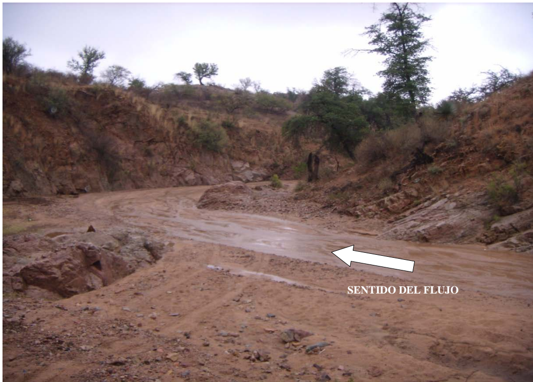
Foto 5.2. La cortina se ubicará al dar la vuelta el arroyo, aprovechando las márgenes rocosas para hacer el empotramiento y la pérdida de fuerza del agua.
