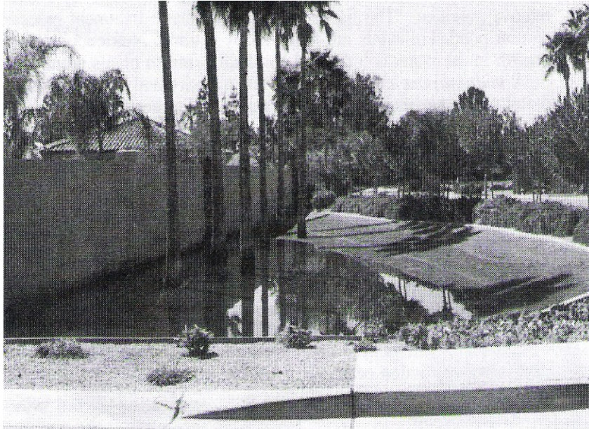
Figura 2.10. La misma cuenca de detención mostrada en la figura anterior, conteniendo ahora un embalse de agua que ocupa aproximadamente el 20% de su capacidad total.
