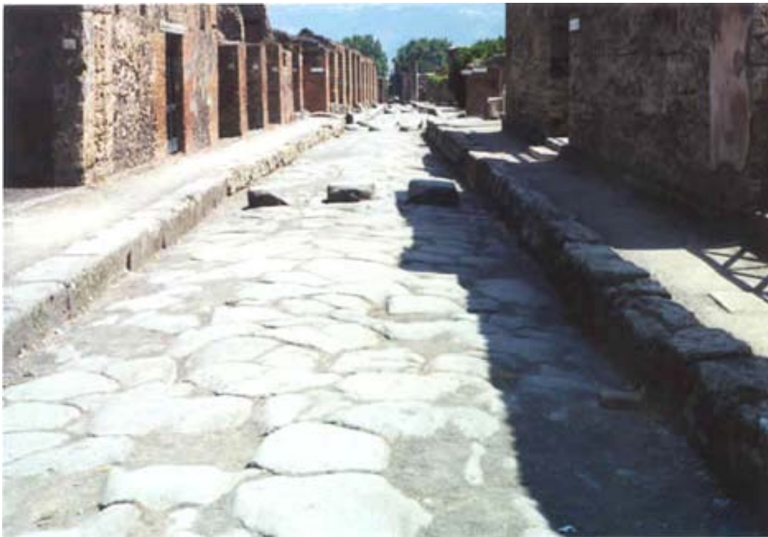
Figura 2.4. Protuberancias de piedra a lo largo de una calle de Pompeya, con el fin de atenuar la energía del agua desplazándose por ella.
