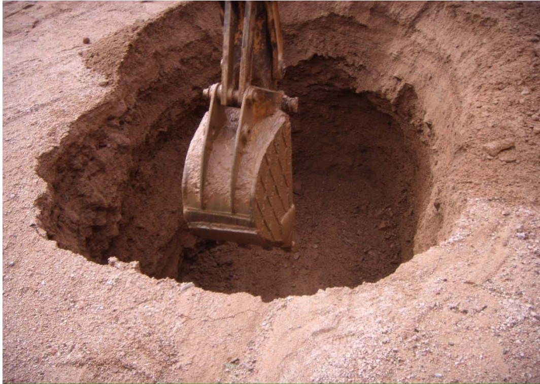
Foto 5.8. Sondeo de exploración para identificar el tipo y profundidad del subsuelo donde descansará la cortina. El material clasifica como grava arenosa.
