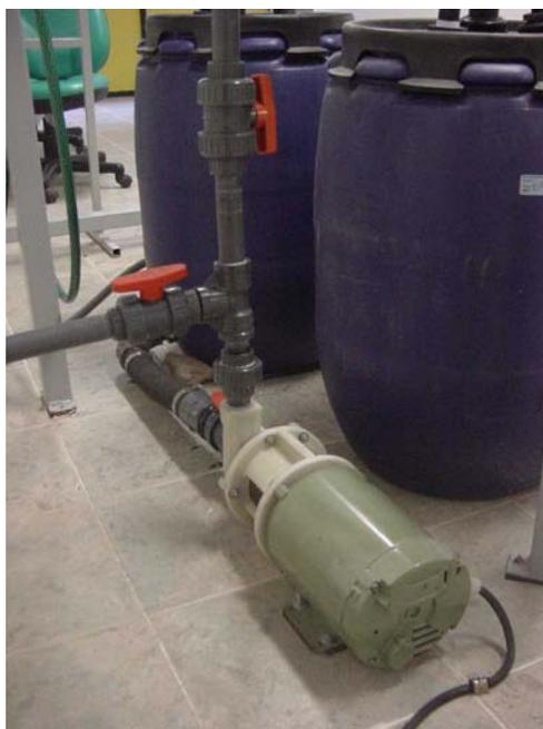
Figura 3.2 Bomba monofásica Alvill de 1 HP
