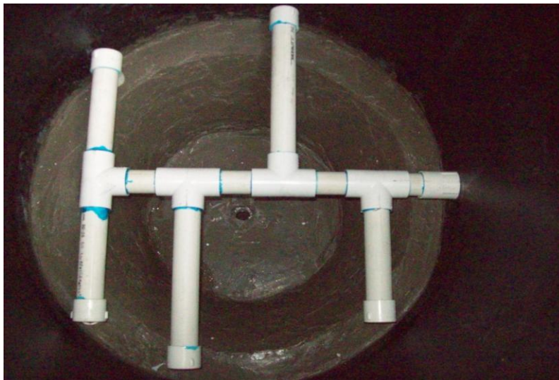
Figura 4.4 Vista interior del sedimentador, se puede observar que no hay penetración de luz.
