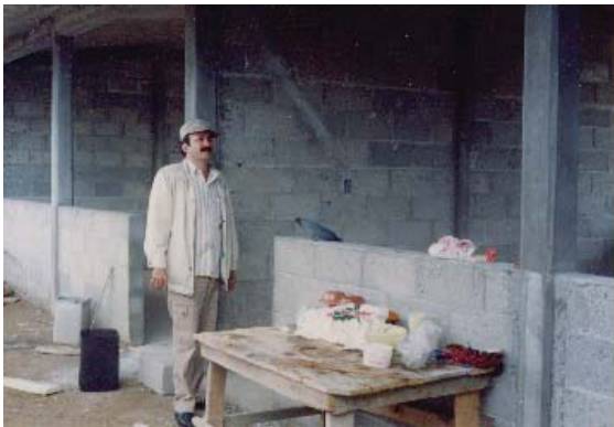
Foto 23. El Arq. Jorge García Olvera supervisando la obra.
