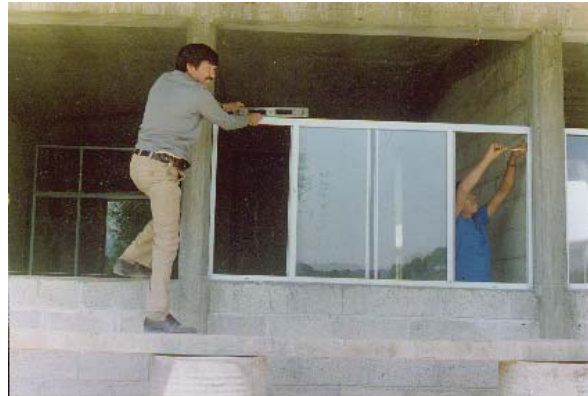
Foto 22. Personal del IMPRAC trabajando en la construcción.
