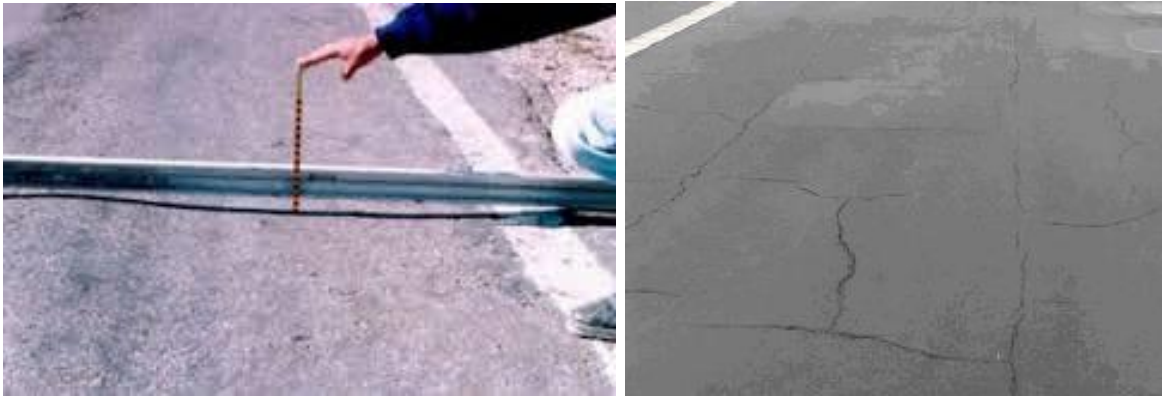
Figura 2.6 Tipos de deterioro de pavimentos por efecto del paso de los vehículos pesados: (a) Deformación plástica o roderas; (b) Fatiga o “calabreo”.
