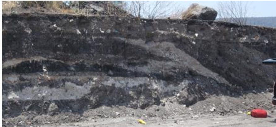
Fig. 6.60 Fotografía del primer caso C1 (relleno antropogénico sobre depósitos aluviales).
