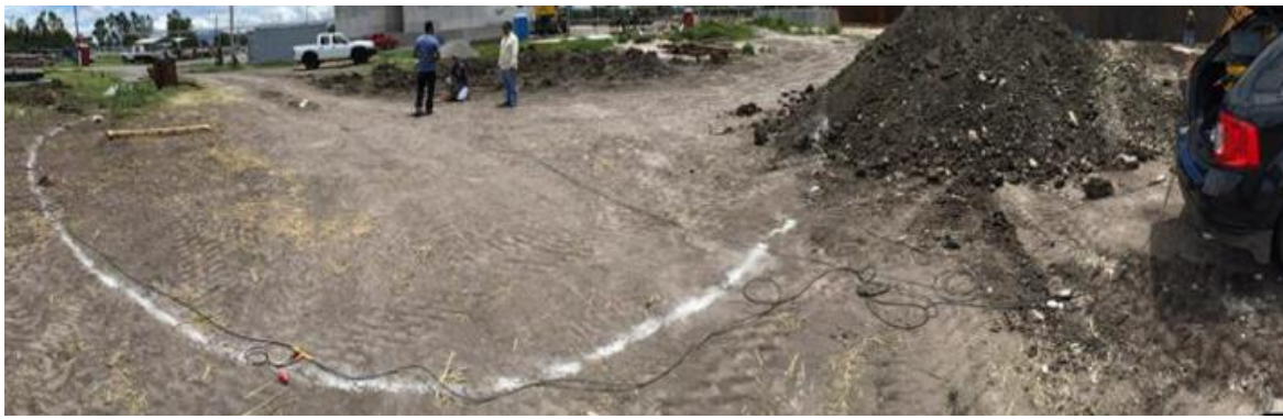
Fig. 6.39 Fotografía durante el desarrollo de los tendidos circulares en el tercer sitio S3.
