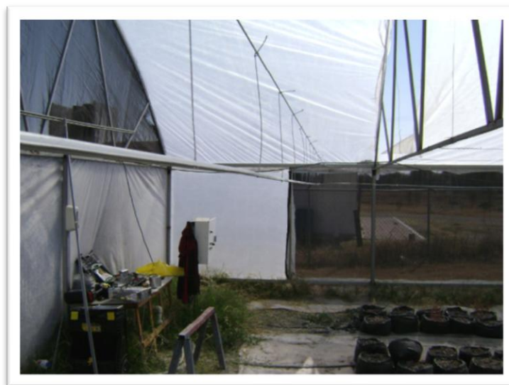
Figura 3.27. Riel montado sobre la estructura del invernadero.
