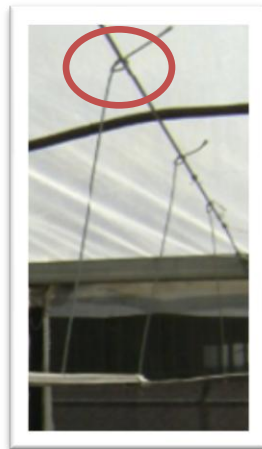
Figura 3.28. Método de sujeción del riel.
