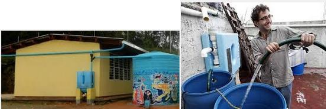
Figura 2.8 los primeros sistemas instalados en México con fines de ayudar a escuelas y poblaciones más necesitadas. (conectanoti)
