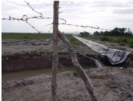
Figura. 2.6 Imagen que muestra la Colección de agua mediante canales de plástico al final de un sembradío. AFRICA ( www2.uah.es )
