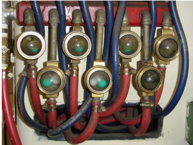
Fig. 57. Agua de enfriamiento.
