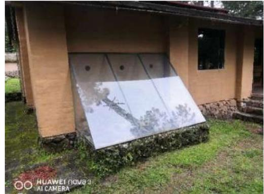
Figura 56. Chimenea solar (Fotografía propia)
