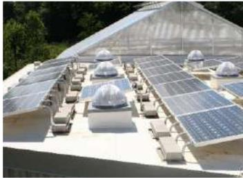
**Luz natural:** El LISD CSF tiene un sistema de generación fotovoltaica que consta de paneles solares montados en el suelo y en el techo. El sistema abastece todas las necesidades eléctricas del edificio (*Center for a Sustainable Future, 2021*).
