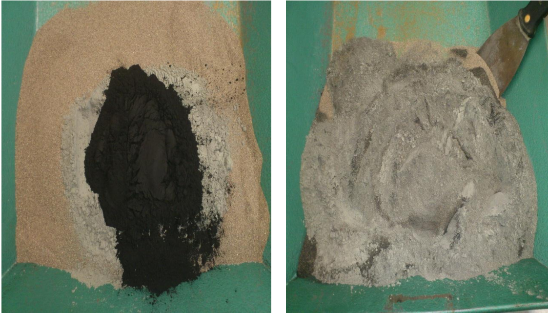
Fig. 26 A la izquierda material sin mezclar para elaboración de mortero. A la derecha material revuelto para obtener una mezcla homogénea.
