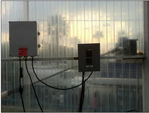
Fig. 24 Nodo 1 de control de motores
