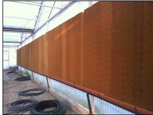
Fig. 9 Muro húmedo de paneles evaporativos.
