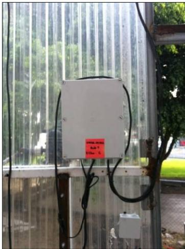
Fig. 26 Nodo 3 de control de motores
