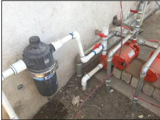
Fig. 8 Bomba para irrigación del muro húmedo
