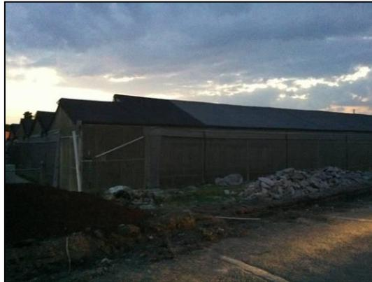
Fig. 4 Techo del invernadero terminado, soporte de malla de alambre + plásticos + malla sombra.
