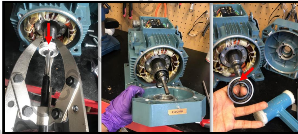
Figura 44. Montaje de rodamiento en el motor con falla a las 12:00
