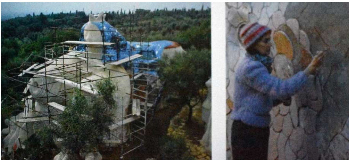
Imagen 29 - La Emperatriz en construcción y Niki dibuja la línea donde se colocarán los azulejos que cubrirán la escultura.
